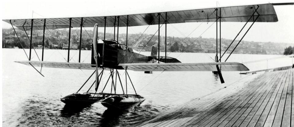
**Slika 1.** Hidrozrakoplov dvokrilac [3]
