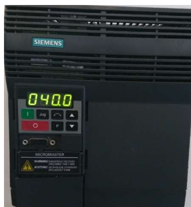
Slika 19. Štimer frekvencije motora aerotunela
