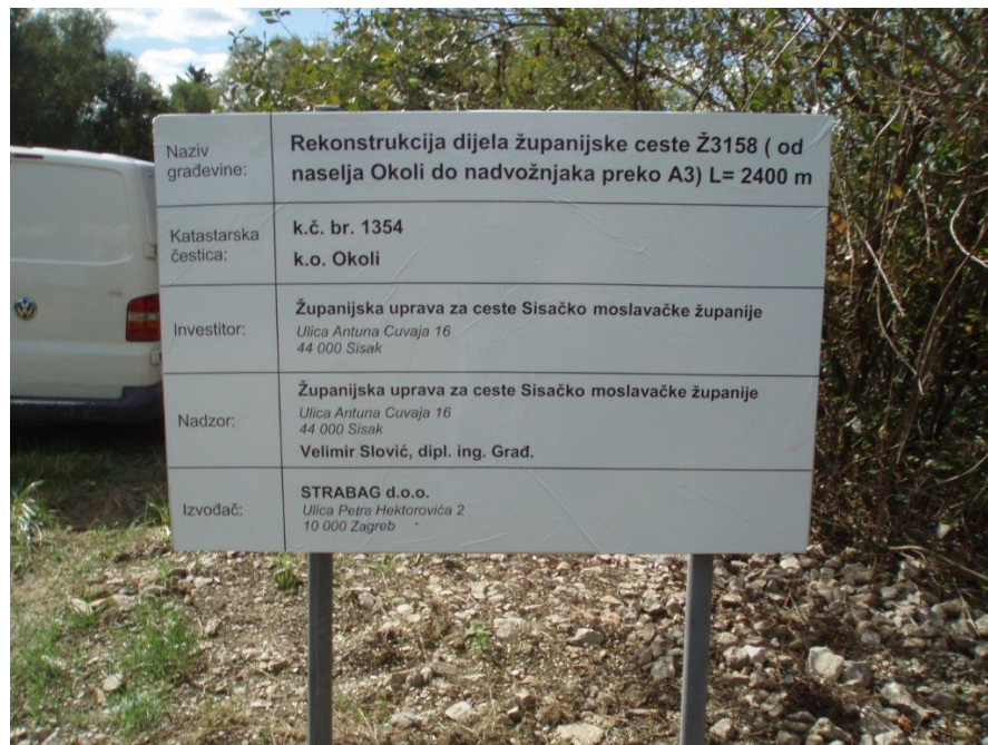
Slika 6. Rekonstrukcija županijske ceste Ž3158, proširenje kolnika
