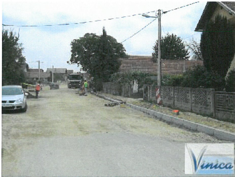
Slika 12. Izgradnja pješačke staze
