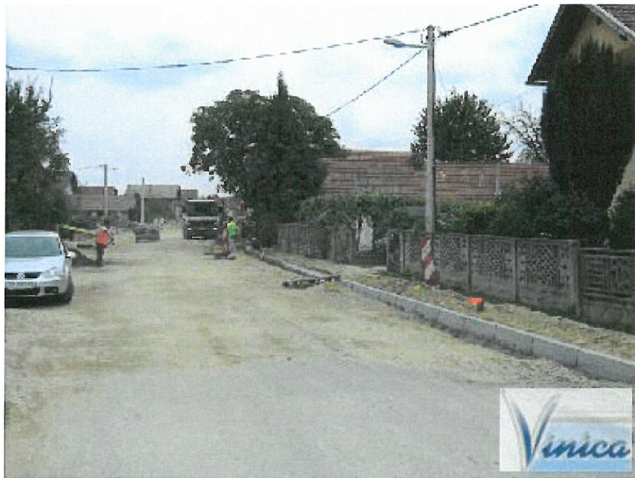
Slika 12. Izgradnja pješačke staze
