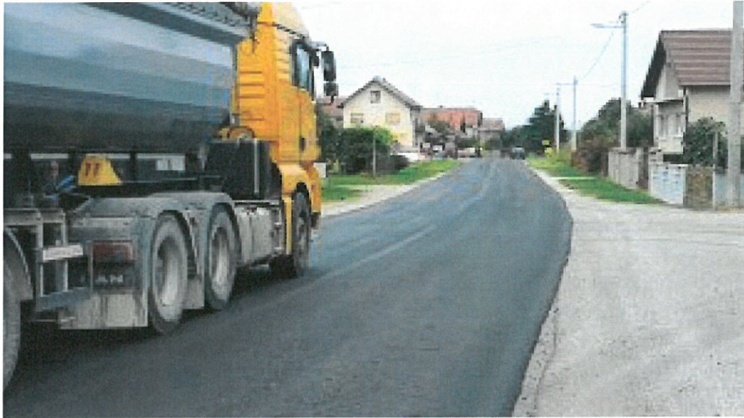
Slika 13. Presvlačenje novim asfaltnim tepihom
