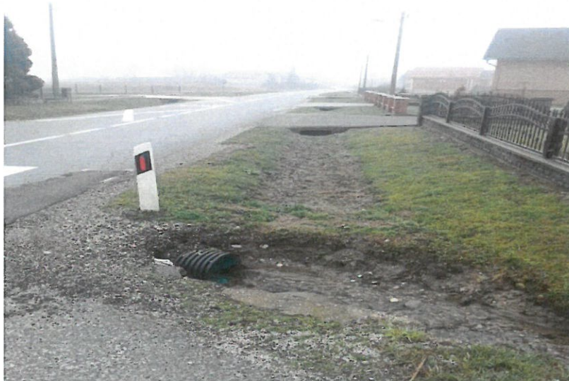
Slika 9. Primjer postojećeg stanja odvodnje
