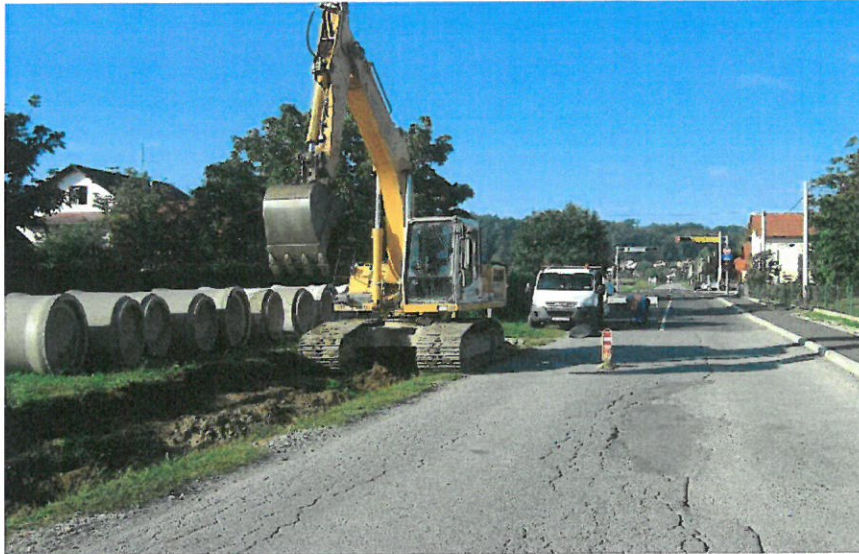
Slika 6. Prikaz postojećeg stanja kolnika županijske ceste 2029
