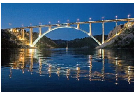
Slika 4. Most Krka (primjer lučnog armiranobetonskog mosta)
