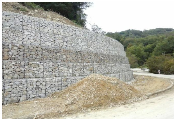
Slika 2. Potporni zid u izgradnji (sanacija državne ceste D29)
