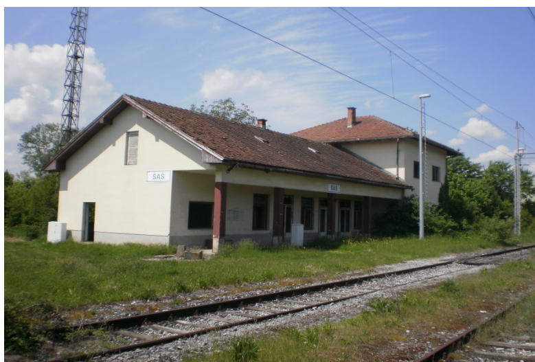
Slika 26: Kolodvorska zgrada u nezaposjednutom kolodvoru Šaš
