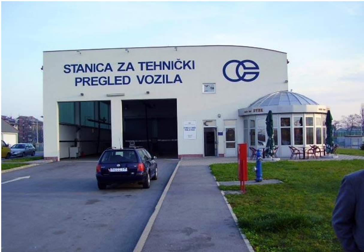
Slika 1. Vanjski izgled objekta stanice za tehnički pregled vozila
