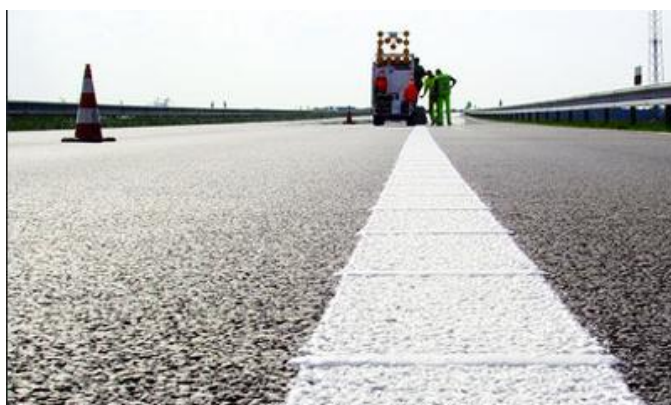
Slika 14. Oznake na kolniku od hladne plastike
