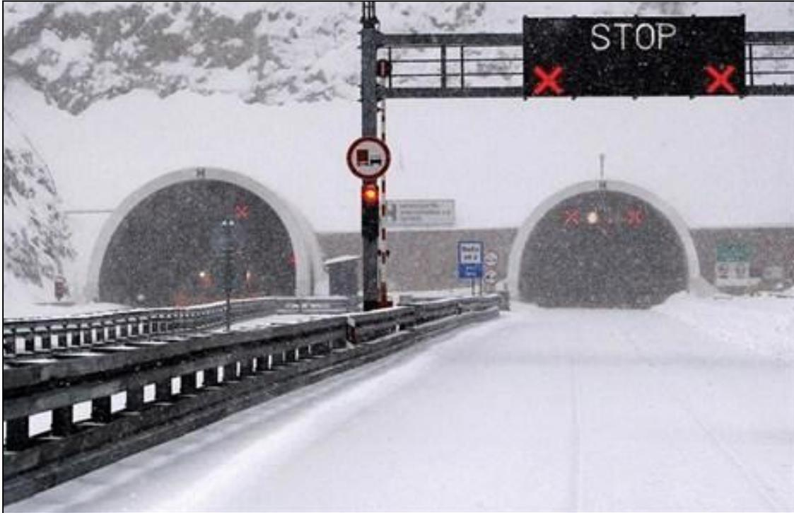
Slika 40. Zatvaranje tunela aktivacijom tunelske opreme, izvor [13]
