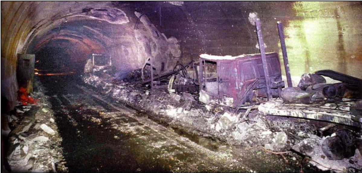
Slika 24. Posljedice požara u tunelu Mont Blanc (1999.), izvor [24]
