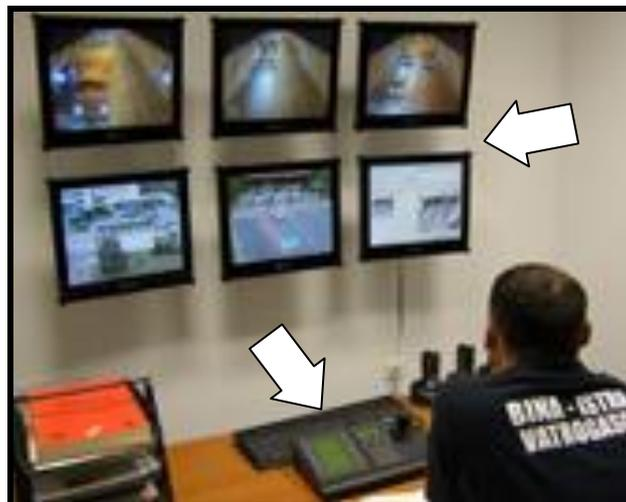
Slika 30. Monitori i upravljački modul video sustava tunela Učka, izvor [29]
