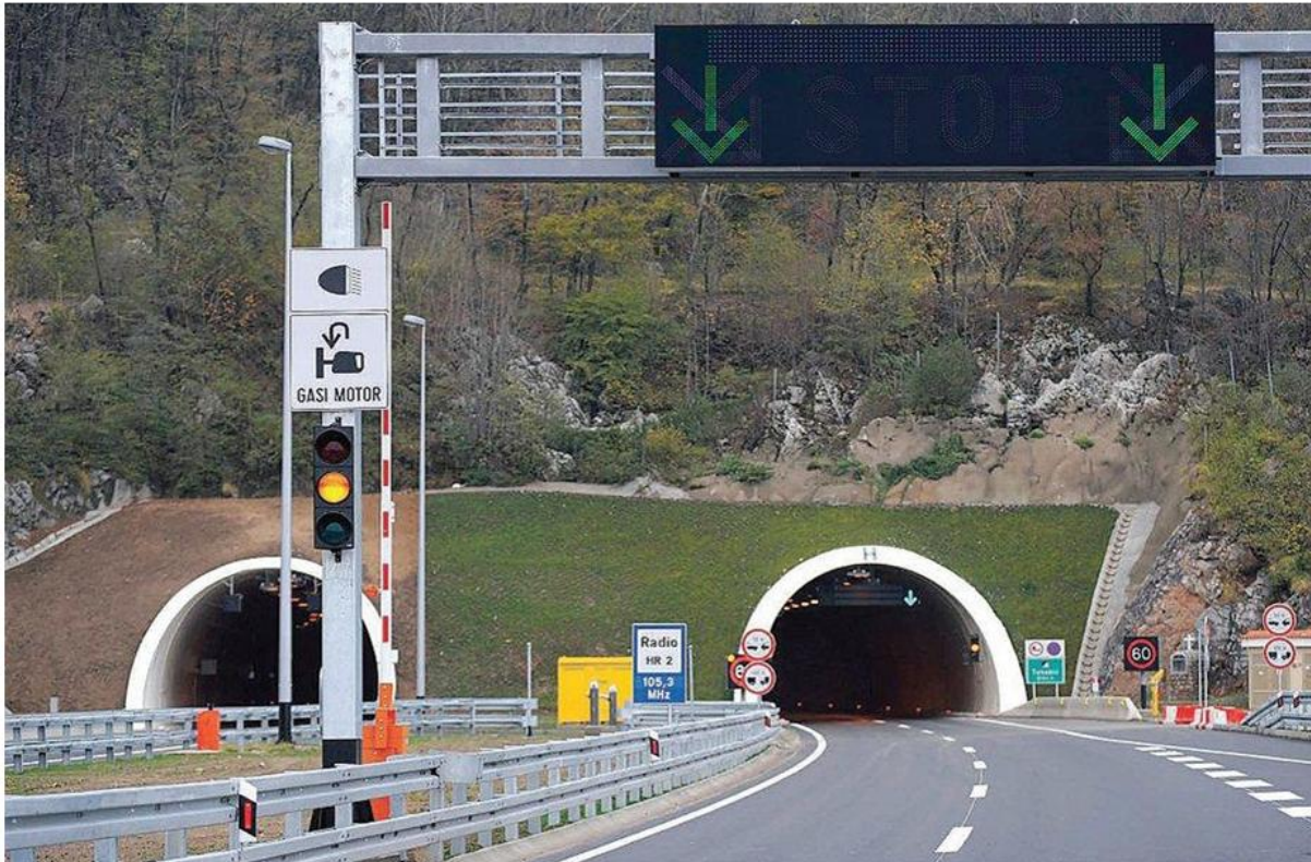
Slika 43. Prometni znakovi, oprema i signalizacija ispred tunela Tuhobić, autocesta A6, izvor [13]
