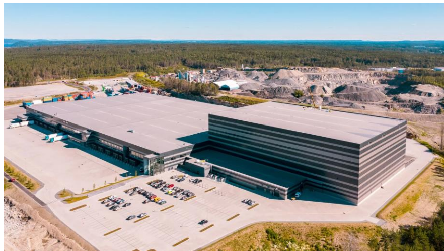
Slika 8. Prikaz vanjskog dijela Centralnog skladišta
