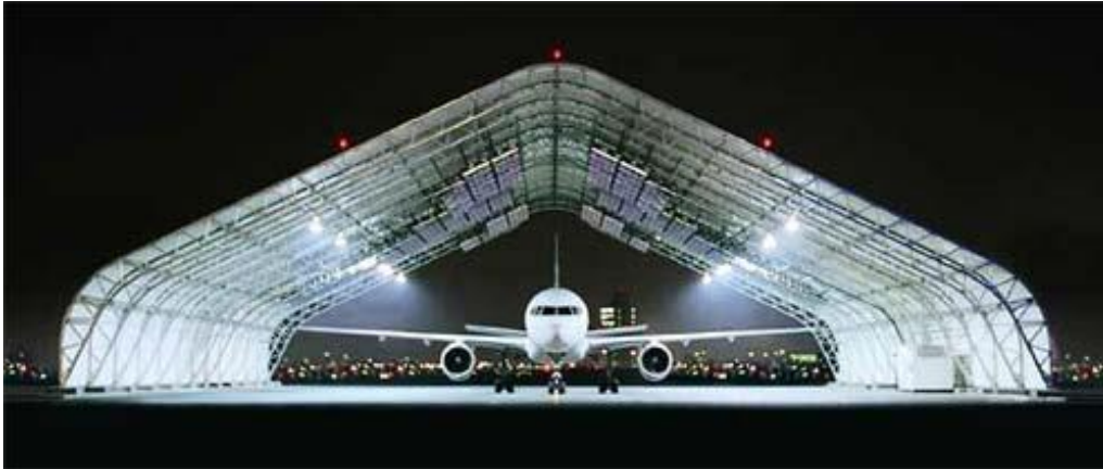
Slika 19. Infracrveni hangar u zračnoj luci Newark, New York, Sjedinjene Američke Države Izvor: [21]
