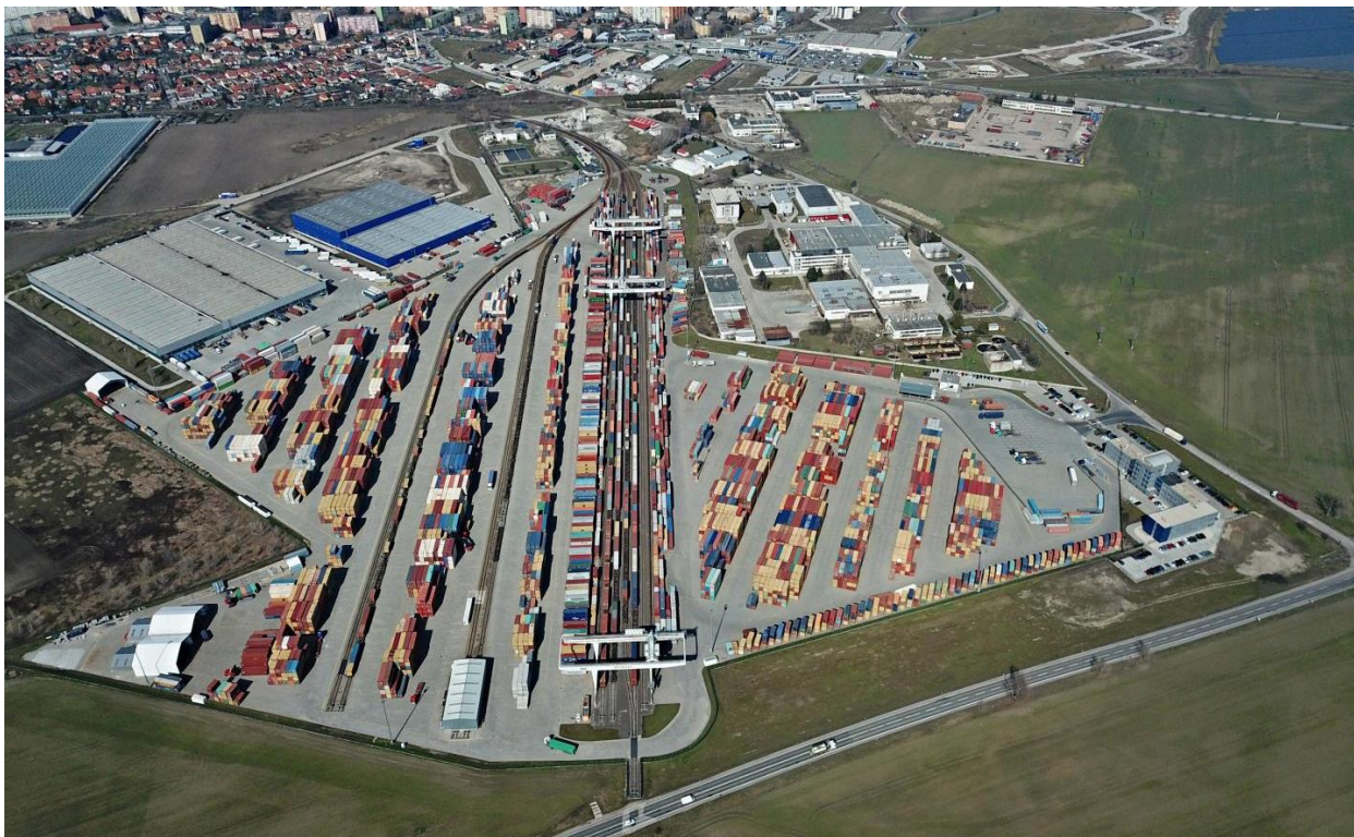
Slika 8 Terminal Metrans Dunajska Streda Izvor: [9]
