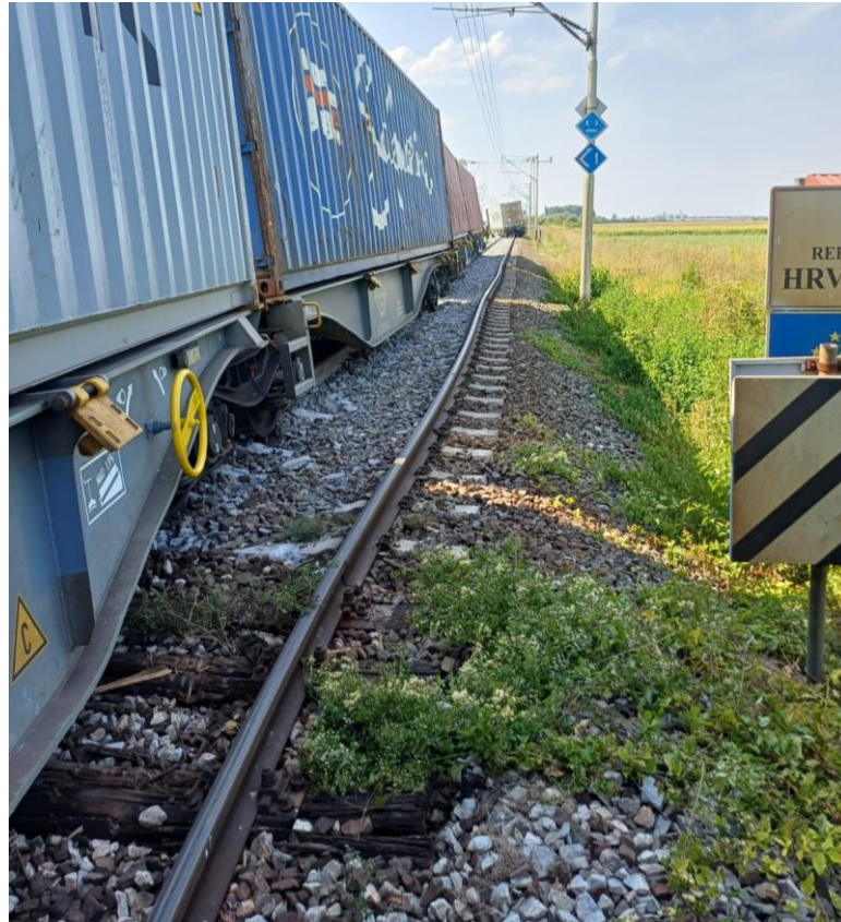
Slika 4. Prikaz iskliznuća vagona između kolodvora Šid i Tovarnik 1, izvor: anonim
