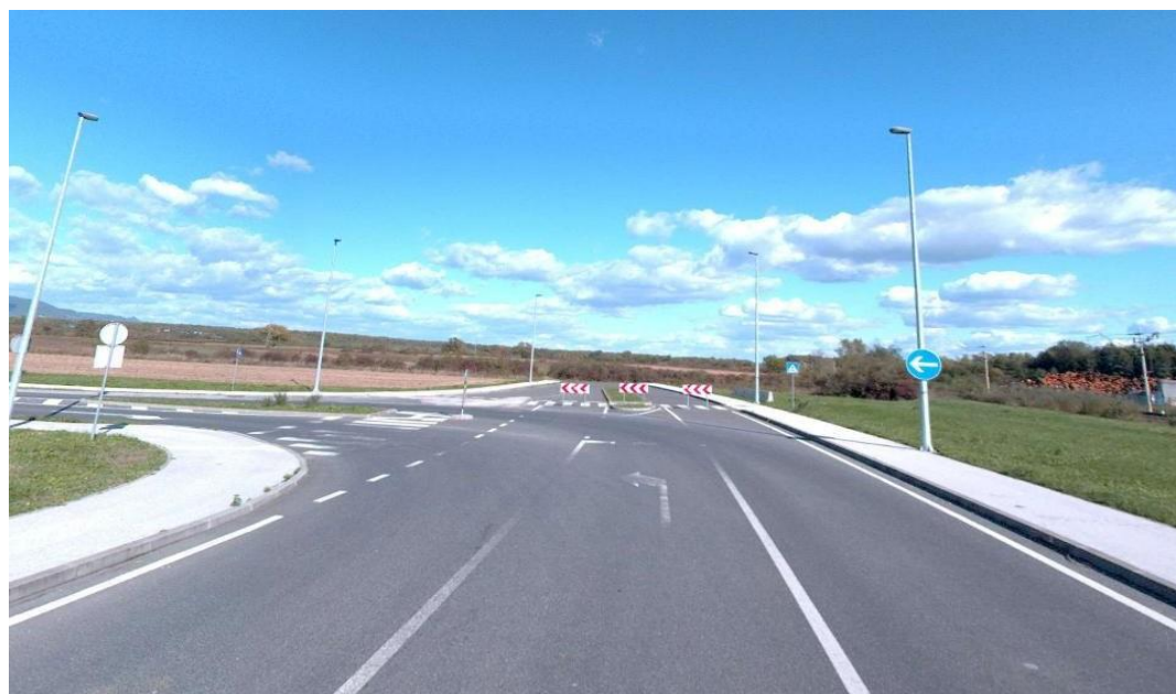
Slika 13. Pogled s privoza 1
