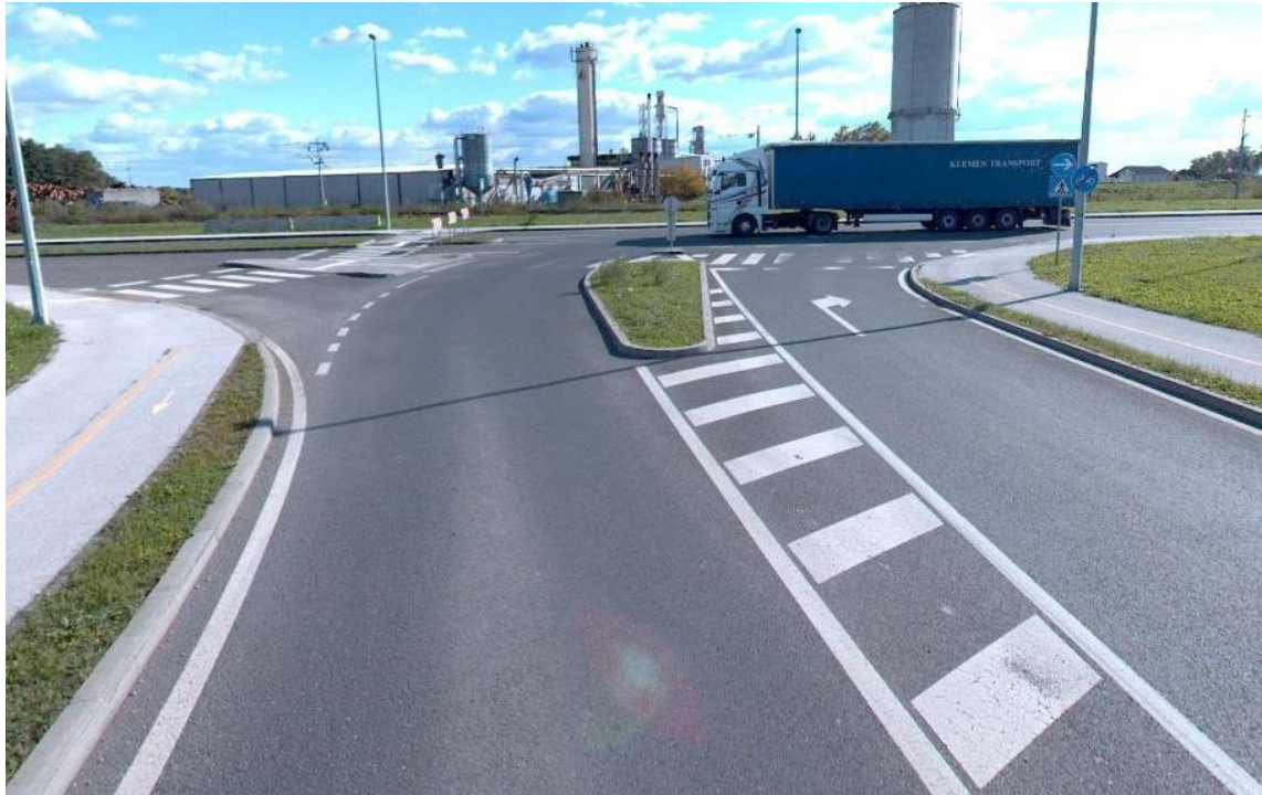
Slika 15. Pogled s privoza 3
