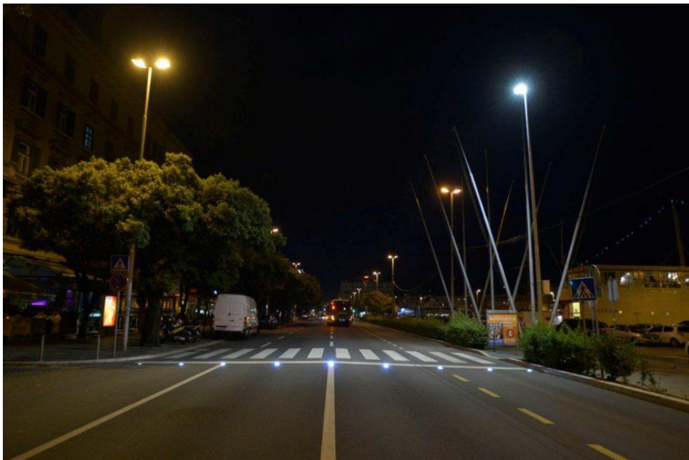
Slika 56. Led markeri na pješačkom prijelazu
