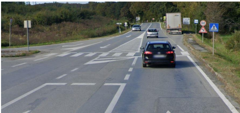
Slika 46. Trenutno stanje na raskrižju
