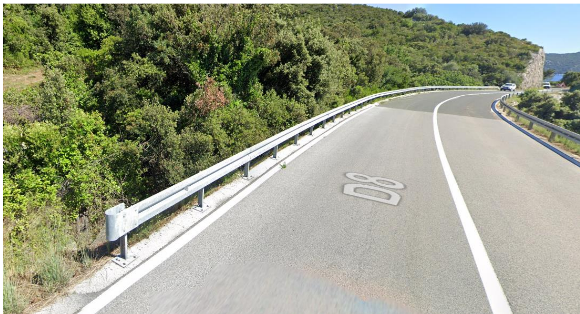
Slika 15. Ispravno izveden završetak/početak čelične zaštitne ograde - Primjer 2 Izvor:[23]
