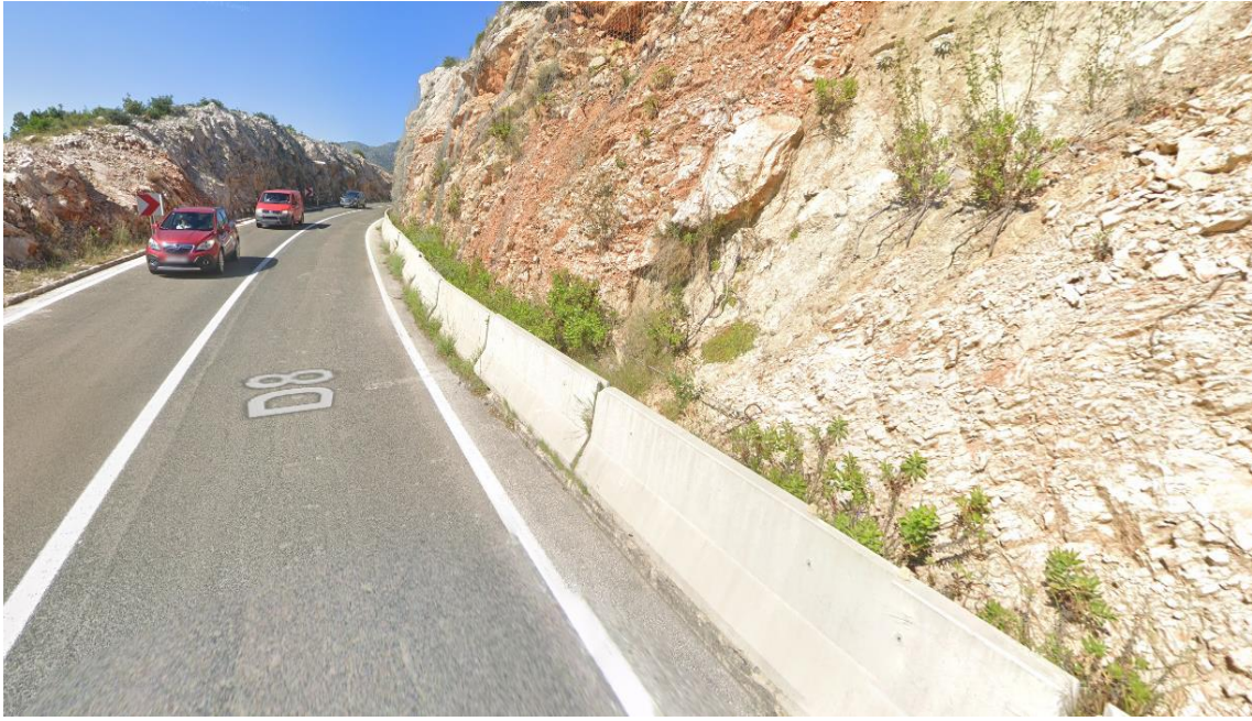
Slika 21. Ispravno izvedena betonska zaštitna ograda - Primjer 2 Izvor:[23]
