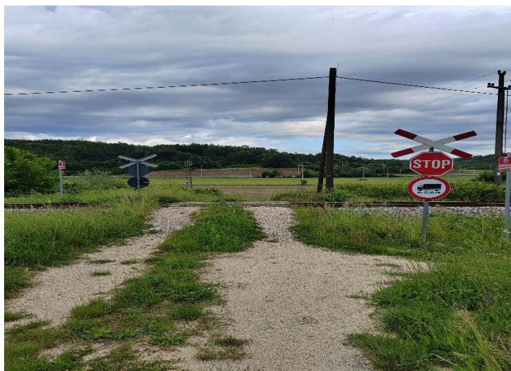
Slika 40. Željezničko-cestovni prijelaz Cerovlje 2
