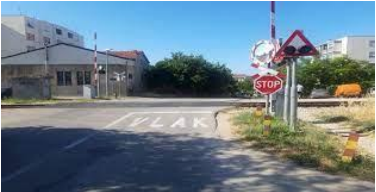
Slika 4. Pasivno osiguran željezničko-cestovni prijelaz [3]
