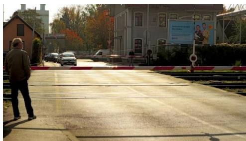
Slika 12. Žcp osiguran svjetlonosno-zvučnom signalizacijom i polubranicima, Cerovlje
