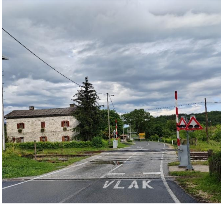
Slika 30. Željezničko-cestovni prijelaz Cerovlje iz smjera sjever
