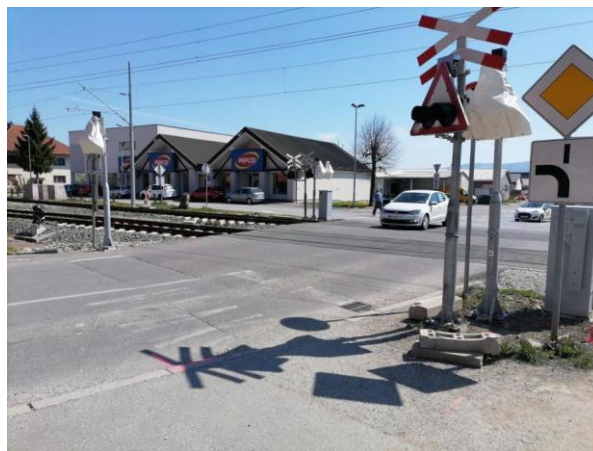
Slika 11. Žcp osiguran svjetlonosno-zvučnom signalizacijom [11]
