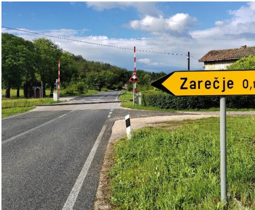
Slika 35. Željezničko-cestovni prijelaz Zarečje iz smjera juga
