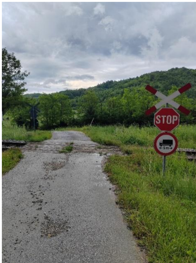
Slika 24. Željezničko-cestovni prijelaz Orlovići iz smjera sjevera
