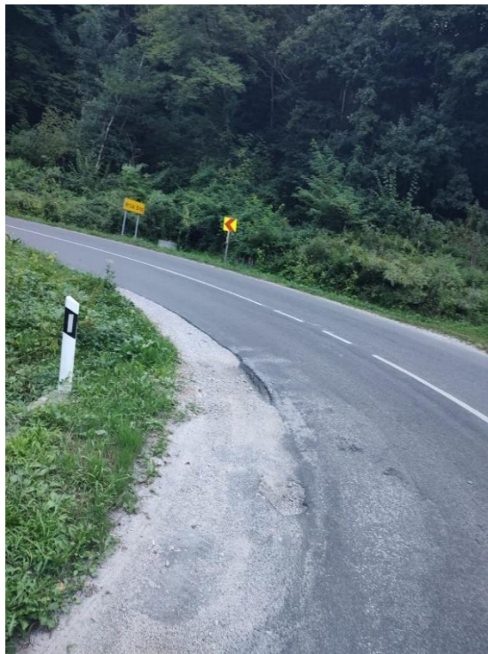
Slika 10: Udarna rupa na bankini na županijskoj cesti ŽC2155 (Hršak Breg)
