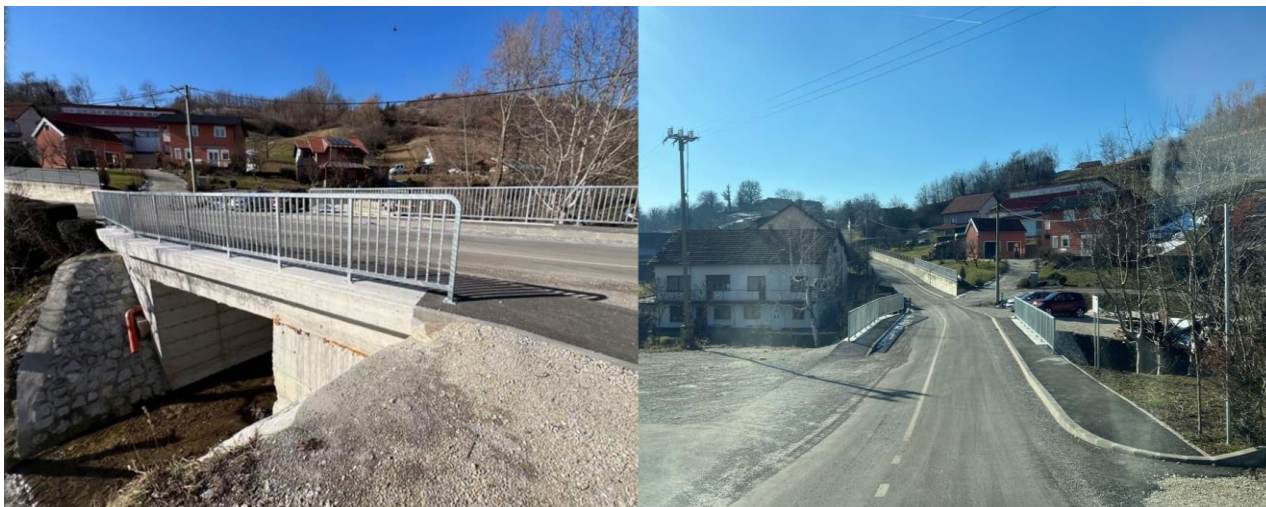
Slika 38: Izgled propusta nakon završene sanacije
