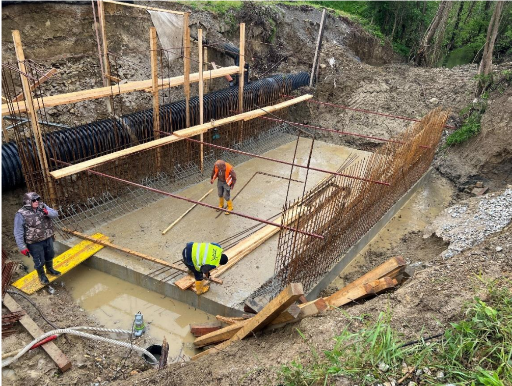
Slika 36: Priprema vertikalnih zidova za beton
