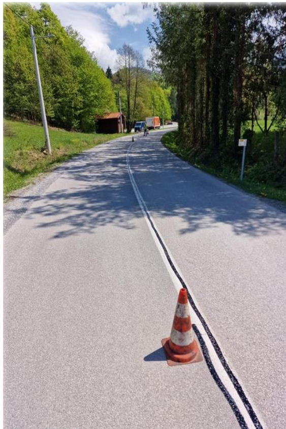
Slika 15: Sanacija pukotina na županijskoj cesti ŽC2219 (Pila)
