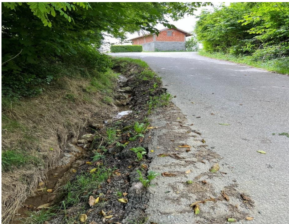
Slika 17: Onečišćeni odvodni jarak
