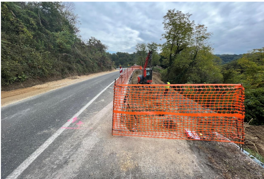
Slika 40: Radovi iskopa i ugradnja armaturnih pilota
