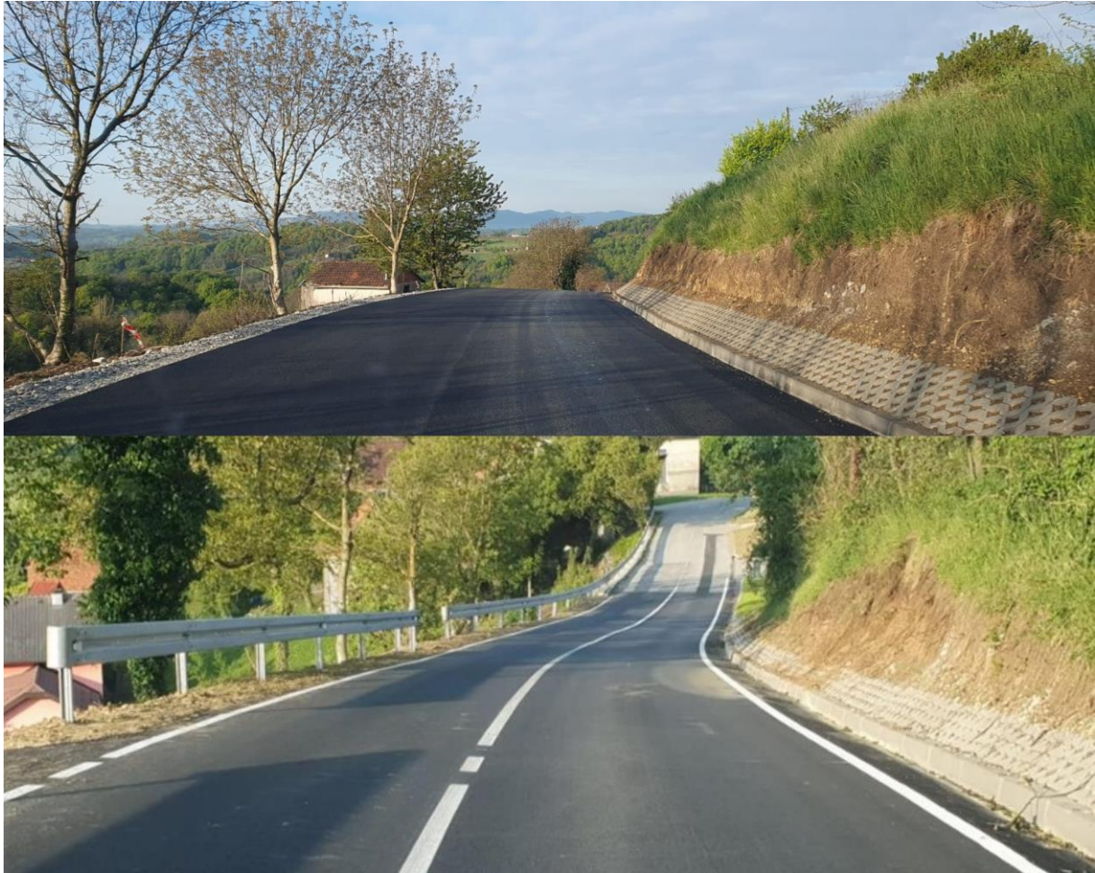
Slika 32: Stanje nakon izvršenih radova sanacije
