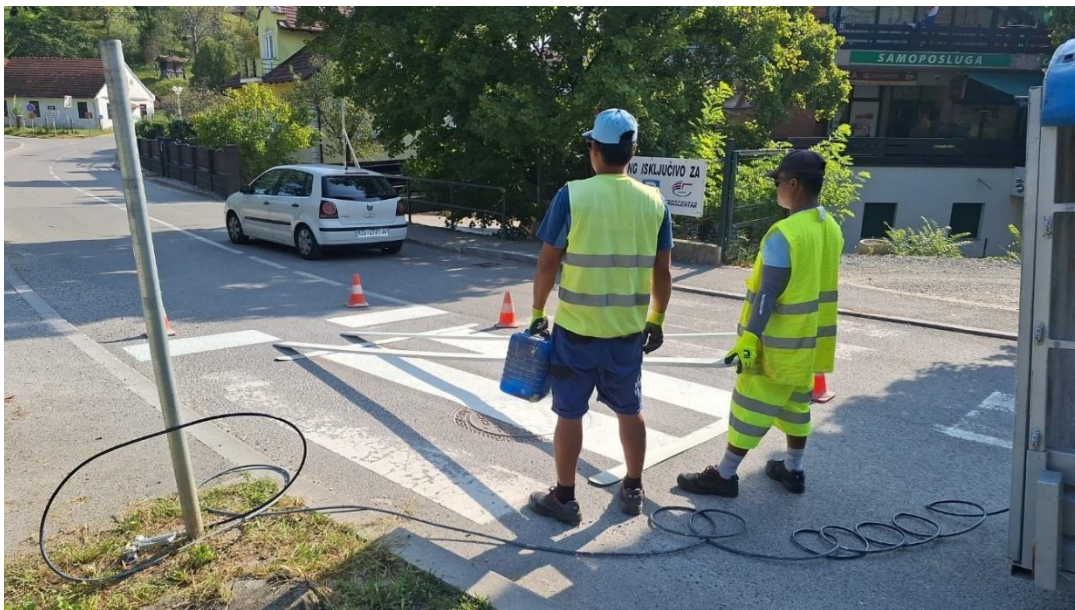
Slika 18: Bojanje pješačkog prijelaza
