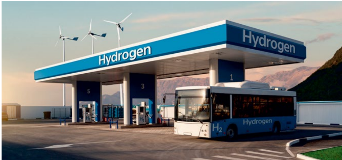
Slika 12. Stanica za punjenje autobusa vodikom
