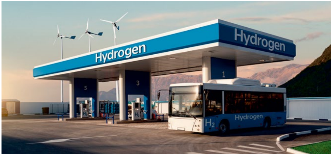
Slika 12. Stanica za punjenje autobusa vodikom
