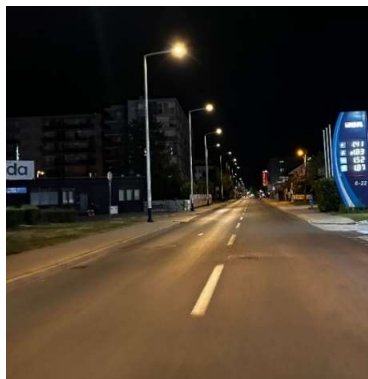
Slika 12. Rasvjeta Zagrebačke ceste
