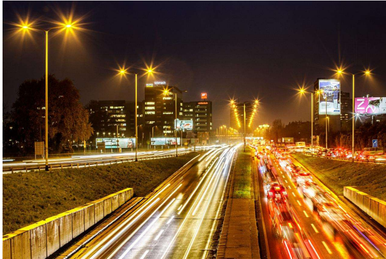
Slika 4. Centralni raspored izvora svjetlosti Izvor: [5]
