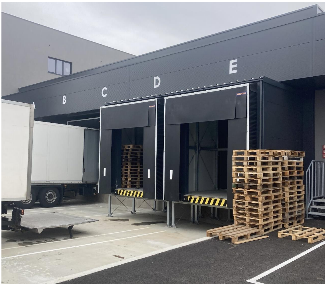
Slika 7. Prijemne rampe za kamione
