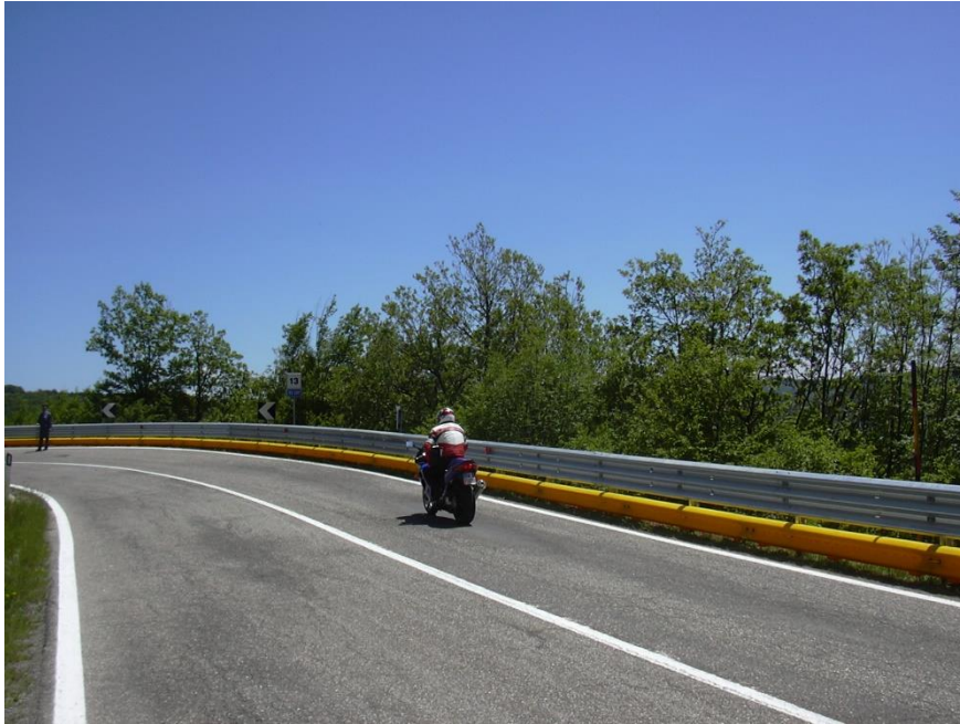
Slika 32. Dodatna zaštita od podlijetanja na zaštitnoj ogradi, [16]
