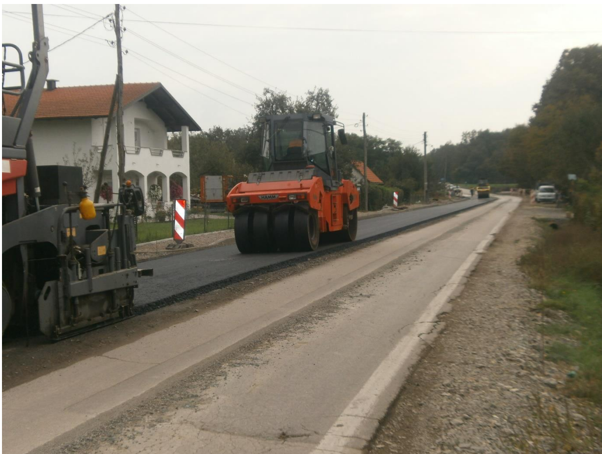
Slika 23. Postavljanje habajućeg sloja asfalta
