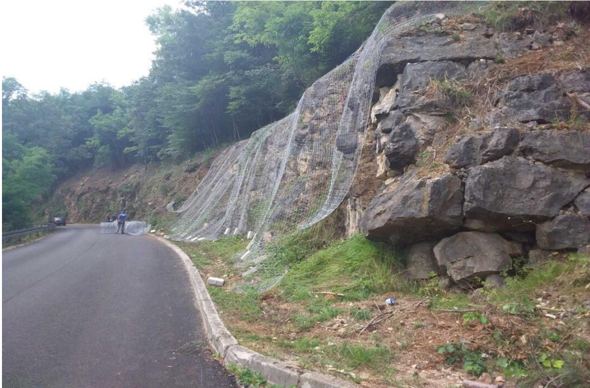
Slika 16. Postavljanje zaštitne mreže
