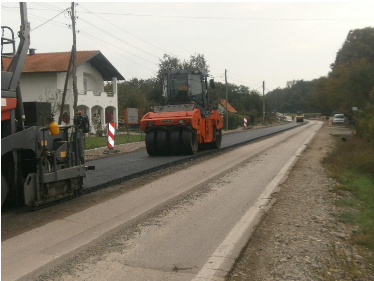
Slika 23. Postavljanje habajućeg sloja asfalta
