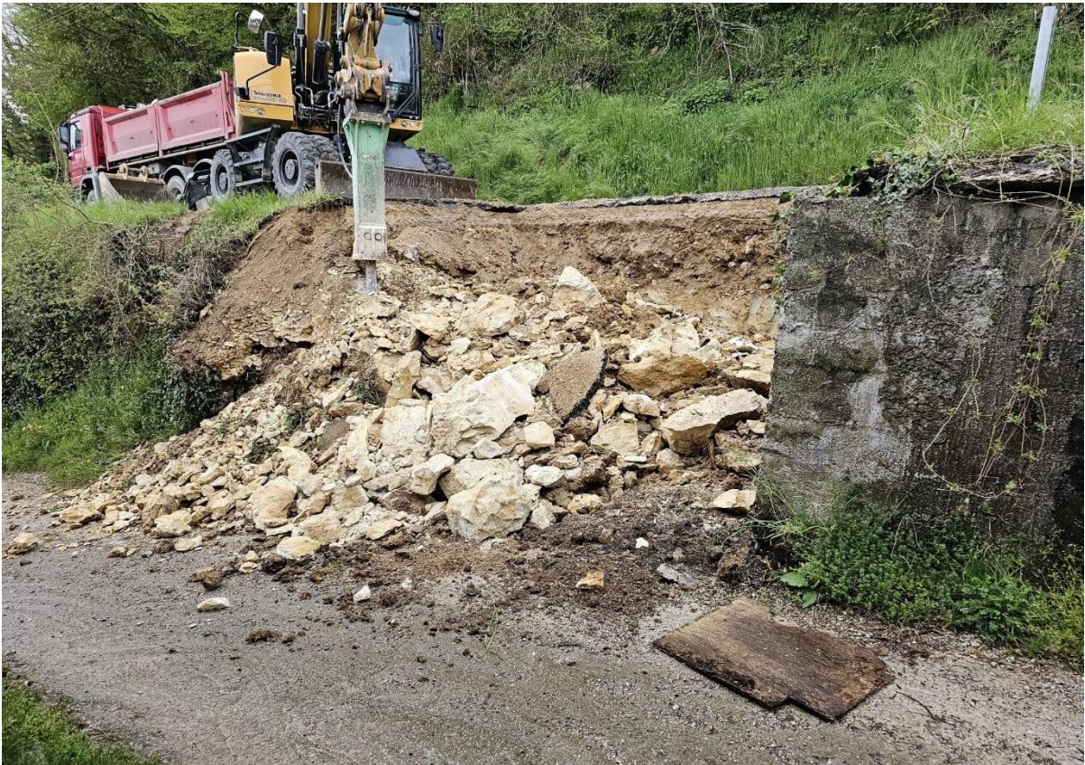
Slika 26. Sanacija ceste kod Ozlja
