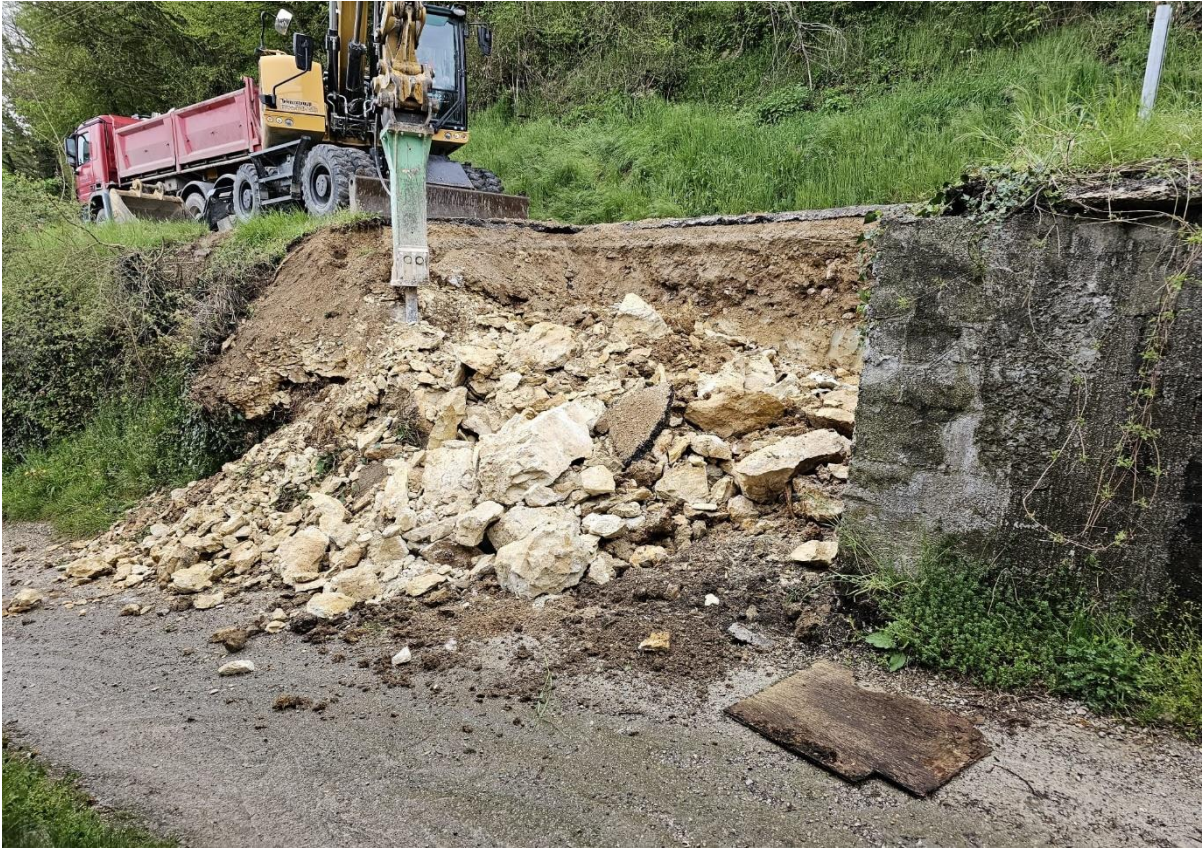
Slika 26. Sanacija ceste kod Ozlja
