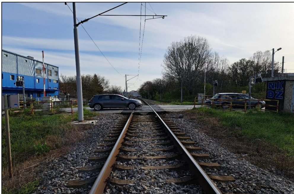
Slika 6. Željezničko-cestovni prijelaz 01 "Mega" smjer Hrvatski Leskovac - Zagreb GK
