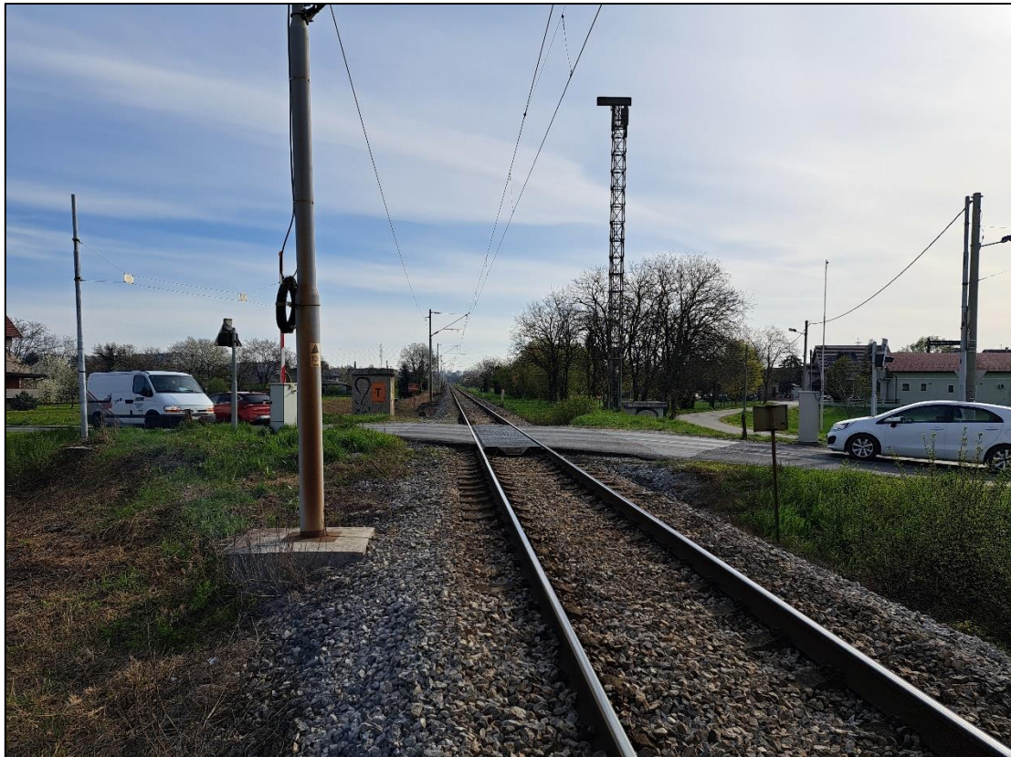
Slika 10. Željezničko - cestovni prijelaz 03 "Botinec", smjer Zagreb GK - Hrvatski Leskovac
