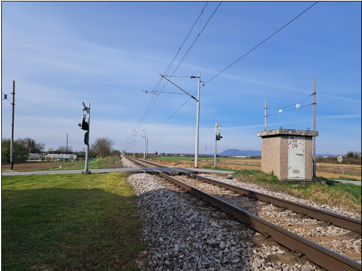
Slika 12. Željezničko - cestovni prijelaz 04 "Kata Mlinarić", smjer Zagreb GK - Hrvatski Leskovac
