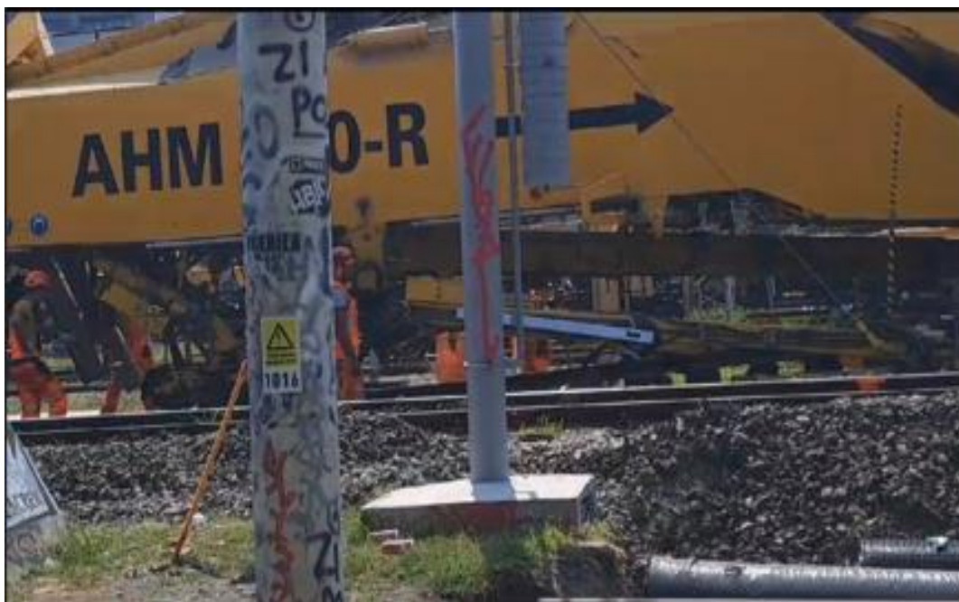
Slika 20. Radovi na donjem ustroju pruge
