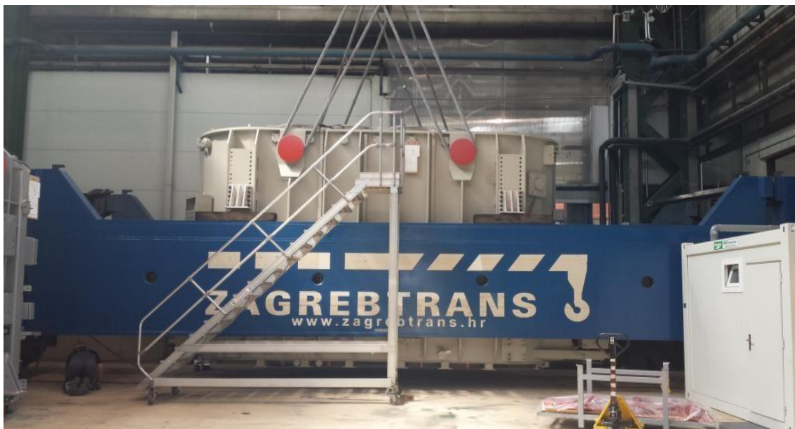
Slika 10. Ukrcanj transformatora Izvor: ZAGREBTRANS d.o.o. 2022.
