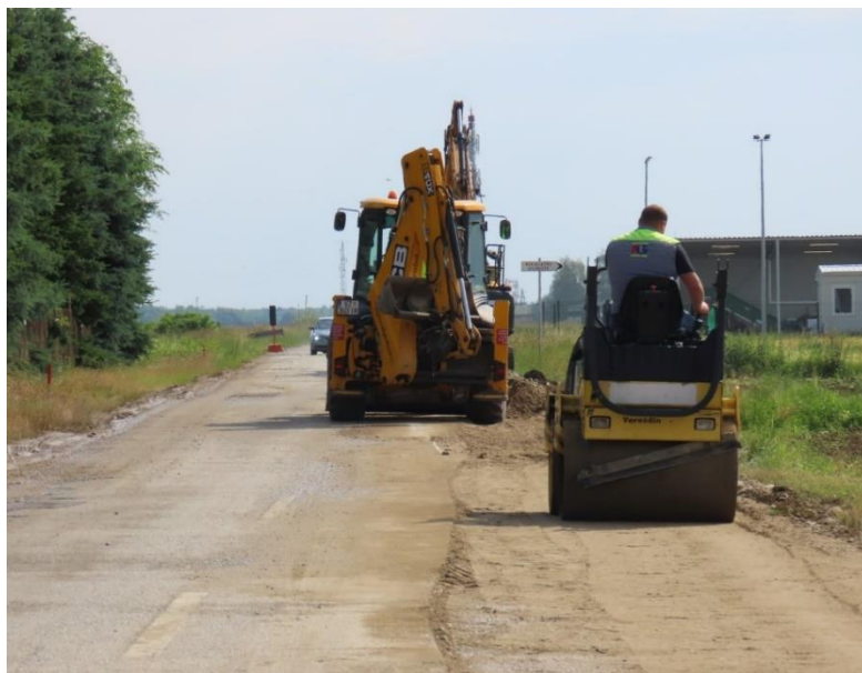
Slika 12: Zamjena kolničkog zastora
