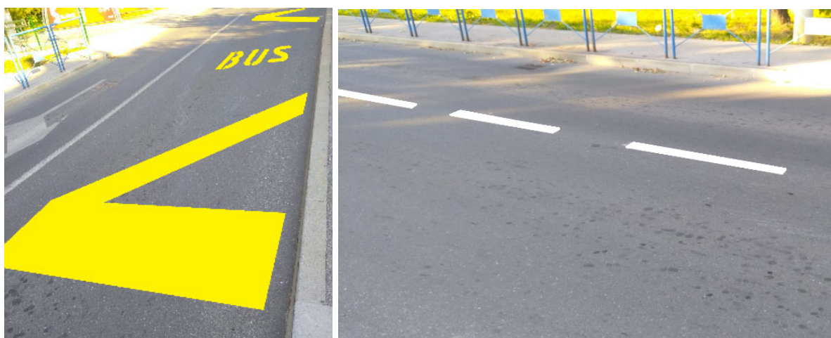
Slika 46. Prikaz obnovljenih oznaka na kolniku
