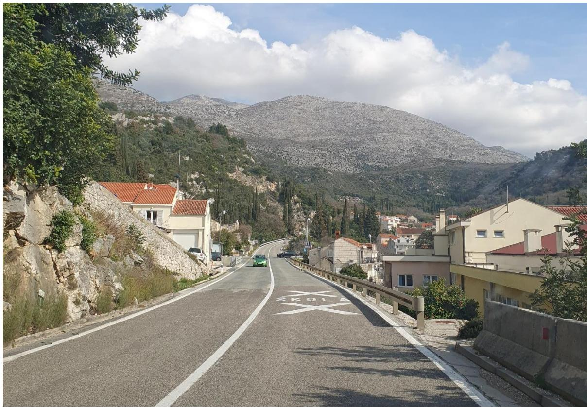
Slika 13. Nezaštićen prostor između čelične zaštitne ograde i betonske ograde „New Jersey“
