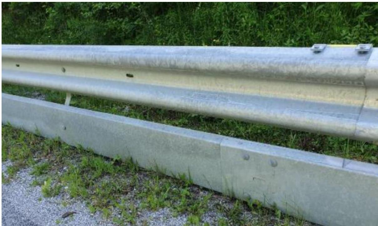
Slika 25. Pravilna izvedba dodatne zaštitne ograda od podlijetanja
