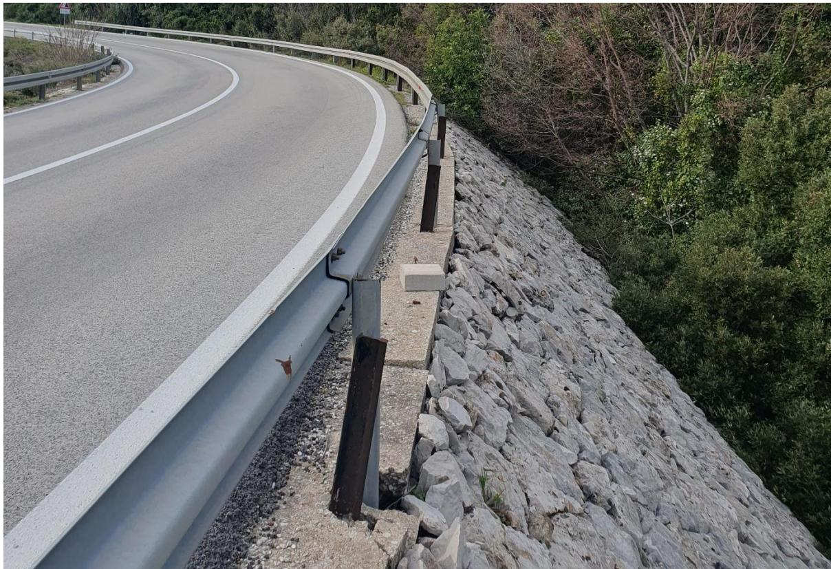
Slika 18. Neuklonjeni nezaštićeni stari stupovi zaštitne ograde
