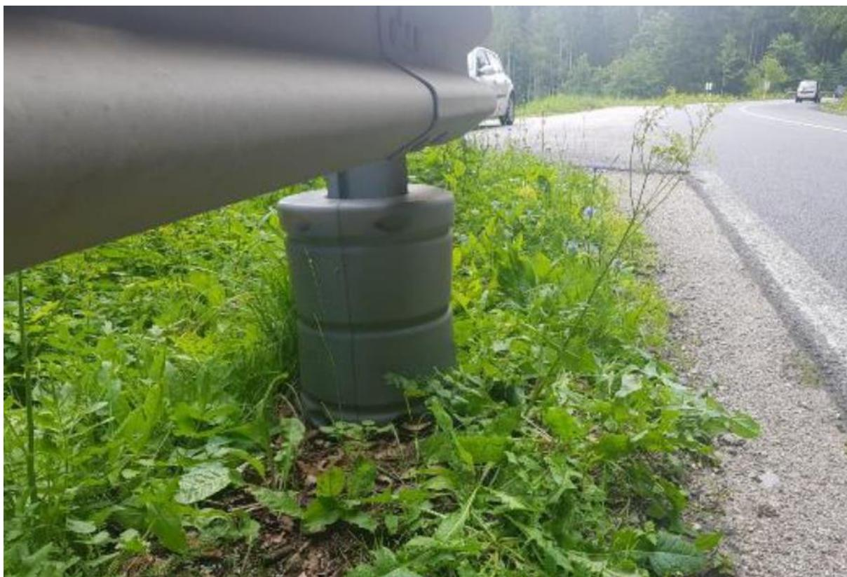
Slika 24. Ublaživač udara postavljen na metalni stup zaštitne odbojne ograde
