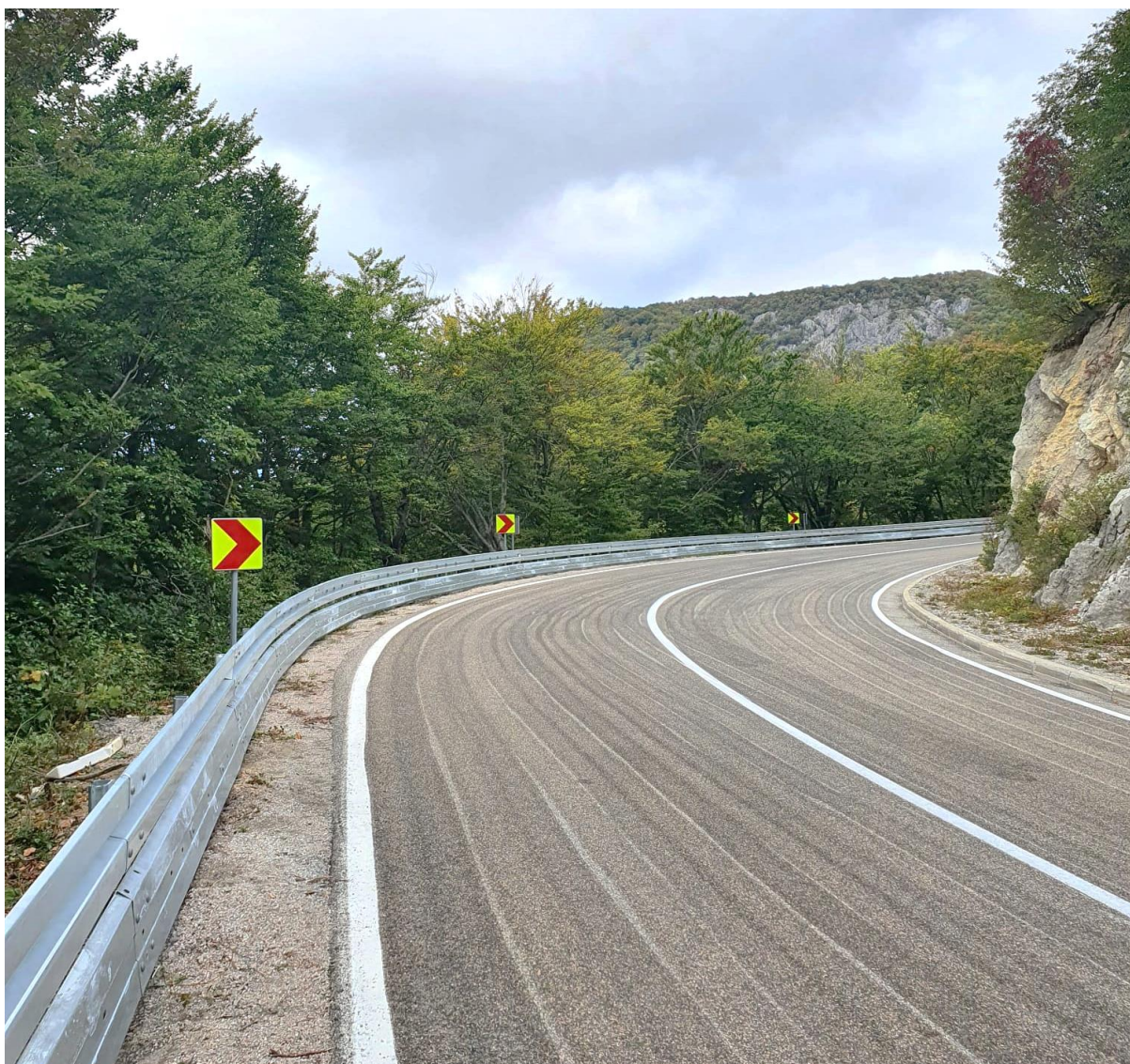
Slika 26. Primjer dobre implementacije dodatne zaštitne ograde za motocikliste na čeličnu zaštitnu ogradu na državnoj cesti DC25 u Ličko-senjskoj županiji
