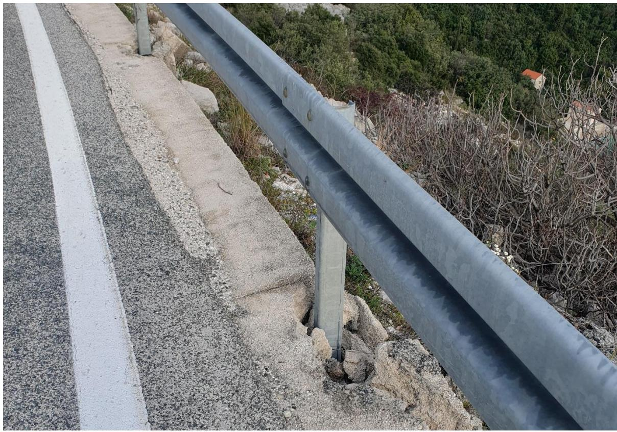
Slika 15. Otkrhnuta betonska podloga (pasica) uz stupove zaštitne ograde
