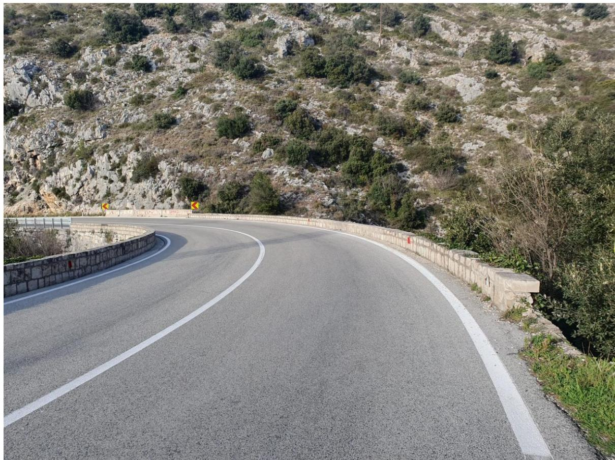
Slika 19. Neadekvatna niska betonska zaštitna ograda s nezaštićenim početkom
