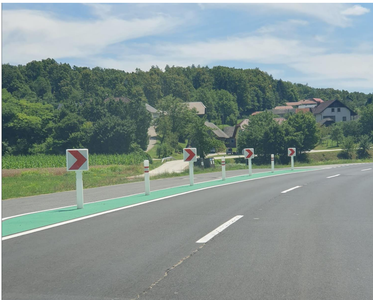
Slika 23. Primjer označavanja zavoja savitljivim smjerokaznim stupićima (K01) i pločama za označavanje zavoja (K10-1) napravljenim od polimernog plastičnog materijala
