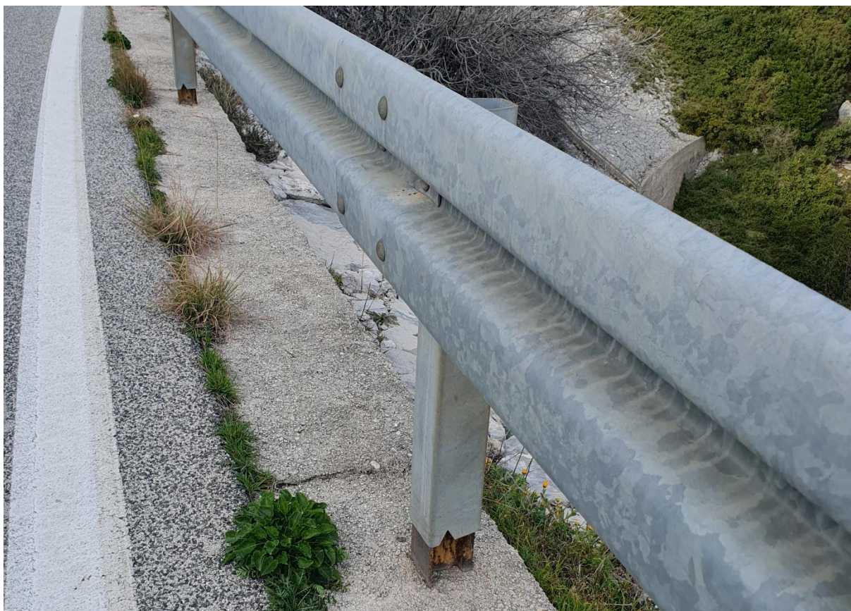
Slika 16. Stupovi zaštitne ograde montirani na postojeće stare stupove
