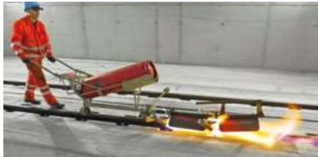
Slika 14. Instalacija modularnih i dugih zavarenih tračnica[16]
