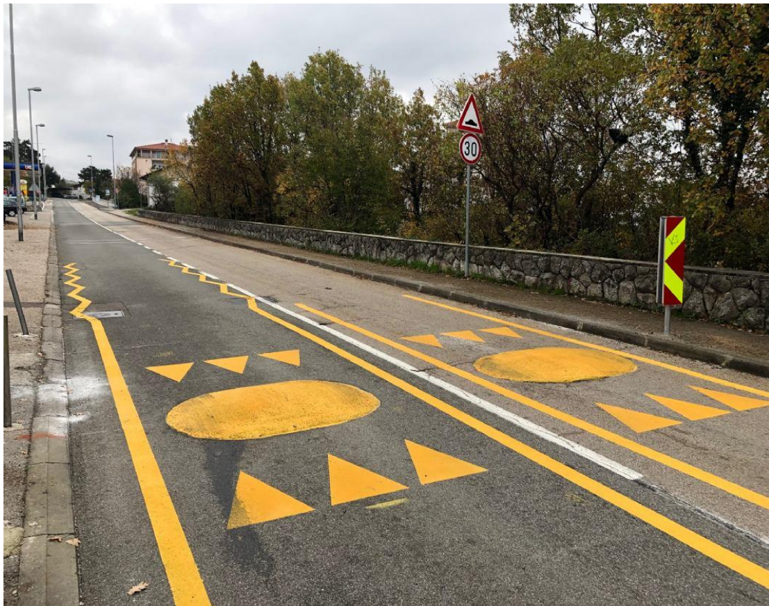
Slika 29. Primjer betonskog usporivača prometa Izvor: [9]
