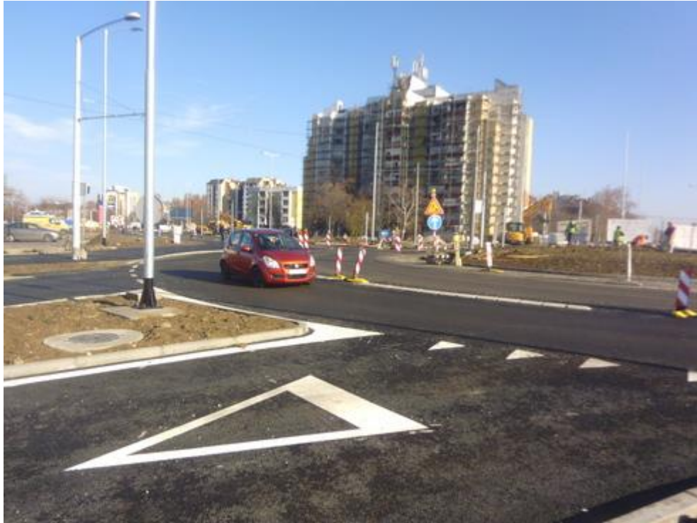
Slika 22. Horizontalna signalizacija - uzdužna oznaka trokuta Izvor: [6]
