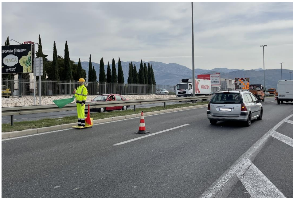
Slika 39: Lutka za privremenu regulaciju prometa
