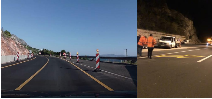
Slika 27: Privremene oznake na kolniku od trake
