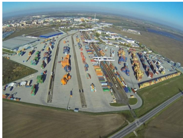
Slika 42: Terminal Dunajska Streda
