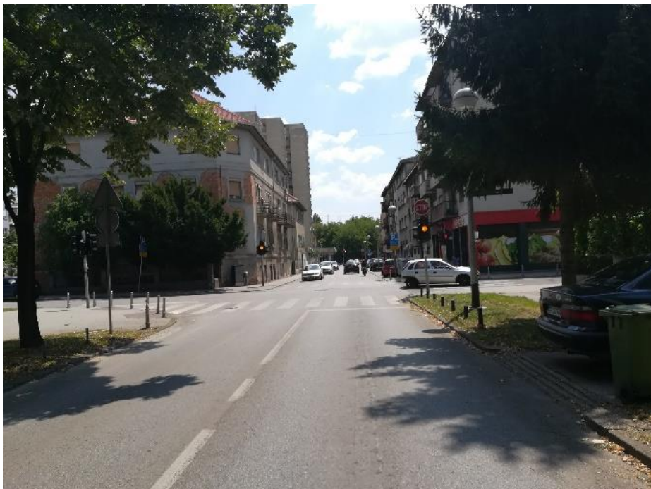
Slika 12. Sjeverni privoz raskrižja Rendićeva ulica – Ulica Jordanovac – Crnčićeva ulica
