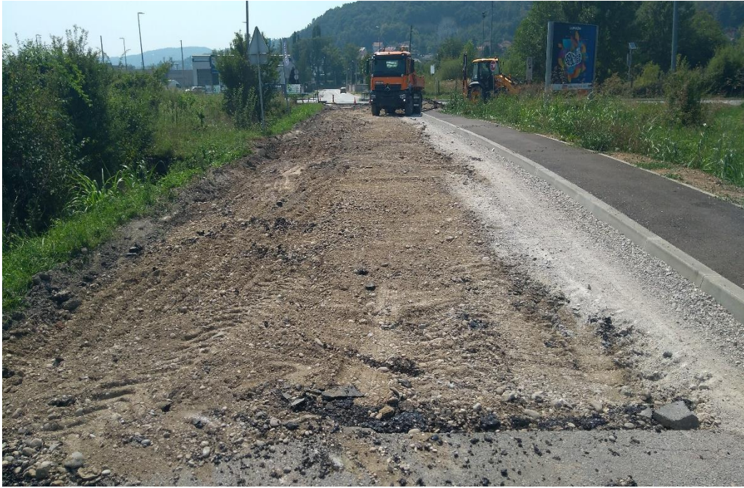
Slika 22. Skidanje kolničkog zastora i podloge
