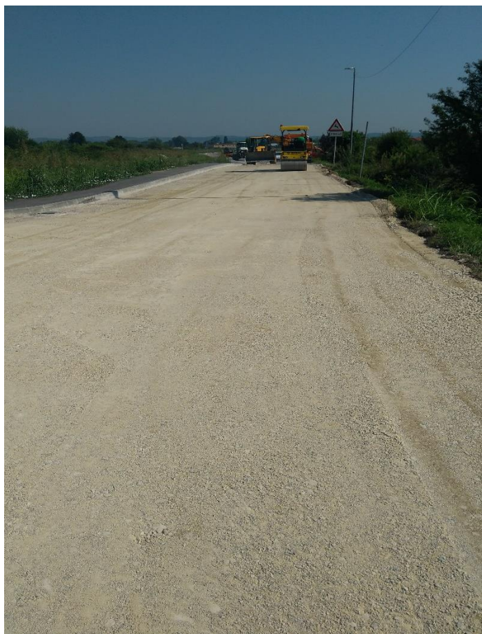
Slika 26. Zbijanje podloge vibrirajućim valjkom
