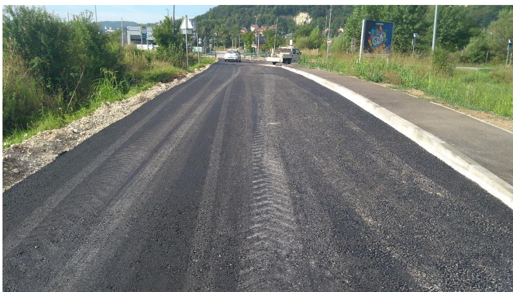
Slika 27. Novi asfaltni zastor
