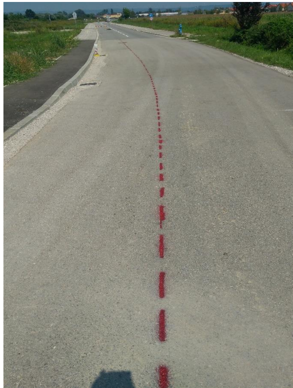
Slika 23. Crta vodilja za rezanje asfalta
