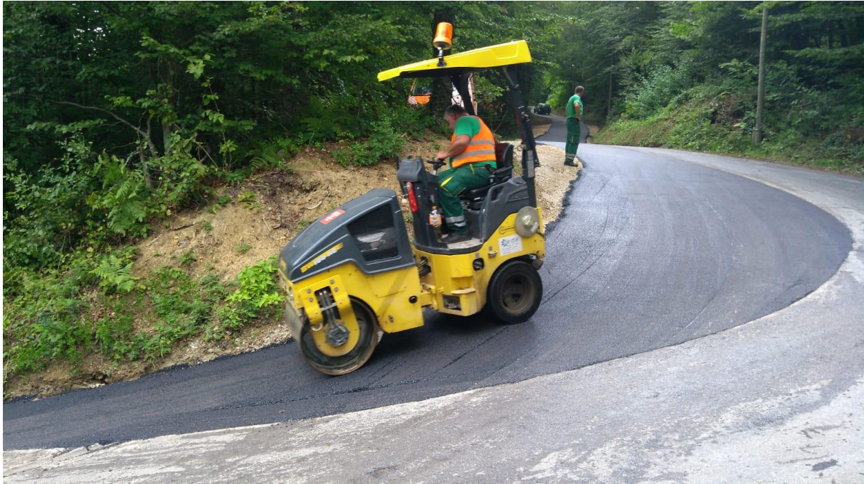
Slika 34. Završno zbijanje vibrirajućim valjkom
