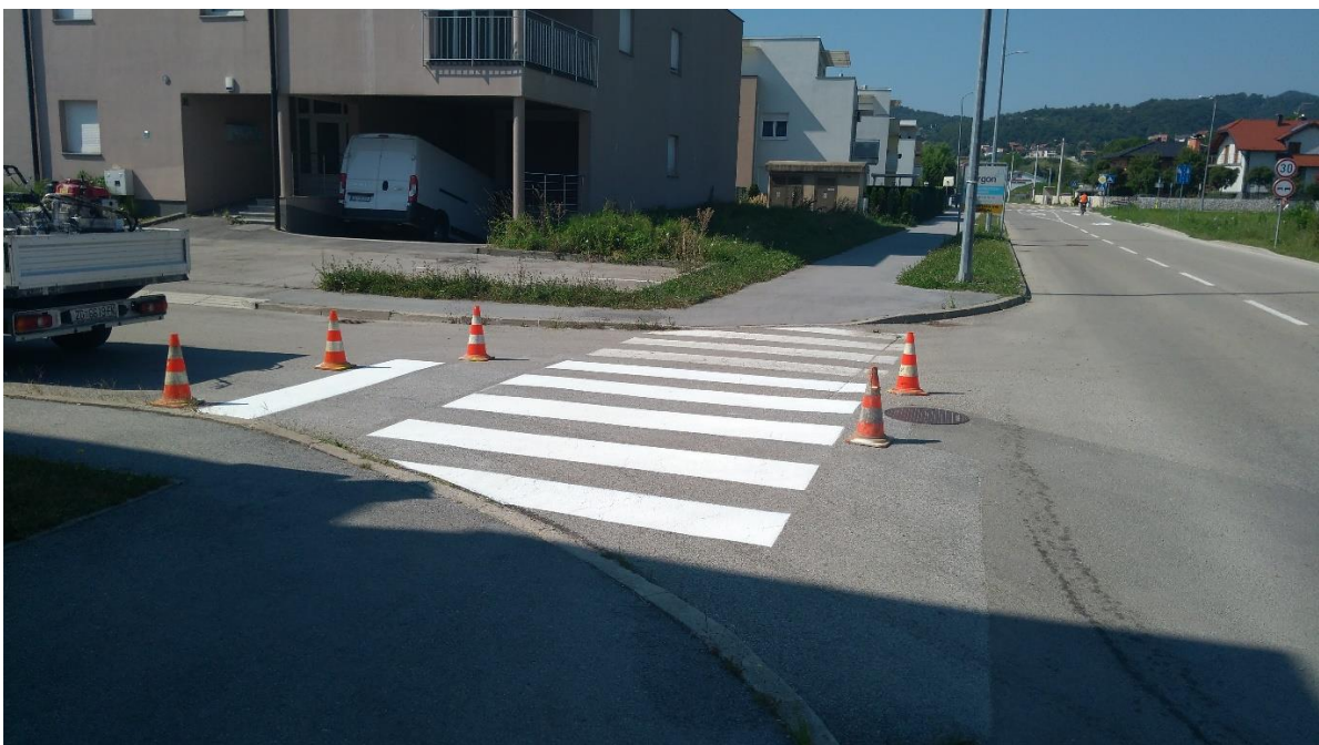
Slika 11. Obnova pješačkog prijelaza u Ulici Ivana Gundulića
