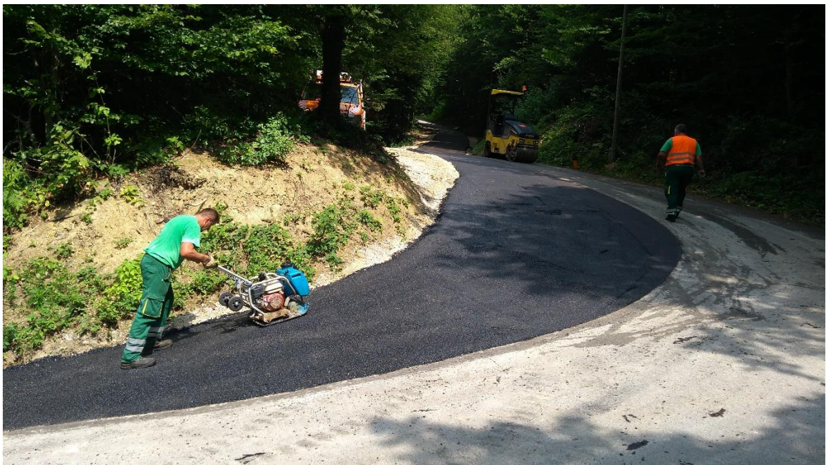
Slika 33. Zbijanje asfalta
