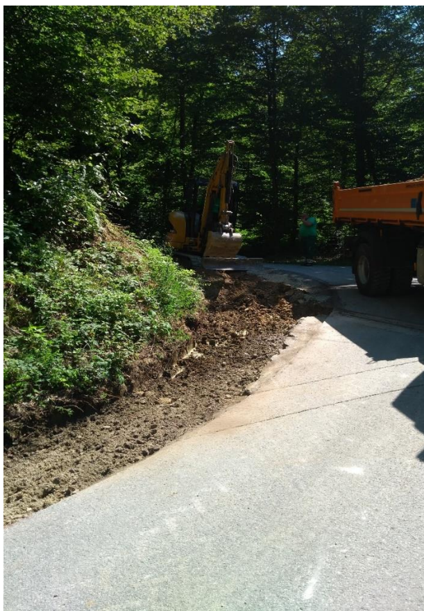
Slika 29. Skidanje materijala mini-bagerom s unutarnje strane zavoja
