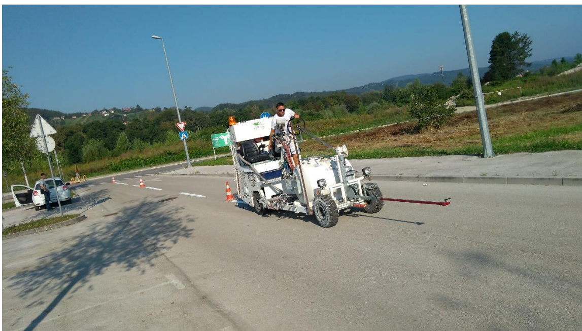
Slika 12. Obnova središnje razdjelne crte u Ulici Rajka Turka
