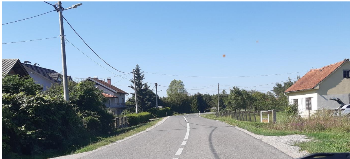
Slika 8. Naseljeno mjesto na ŽC3007 (Ž2217 – Jakovlje – D. Bistra – Novaki Bistranski (Ž2220)) bez nogostupa
