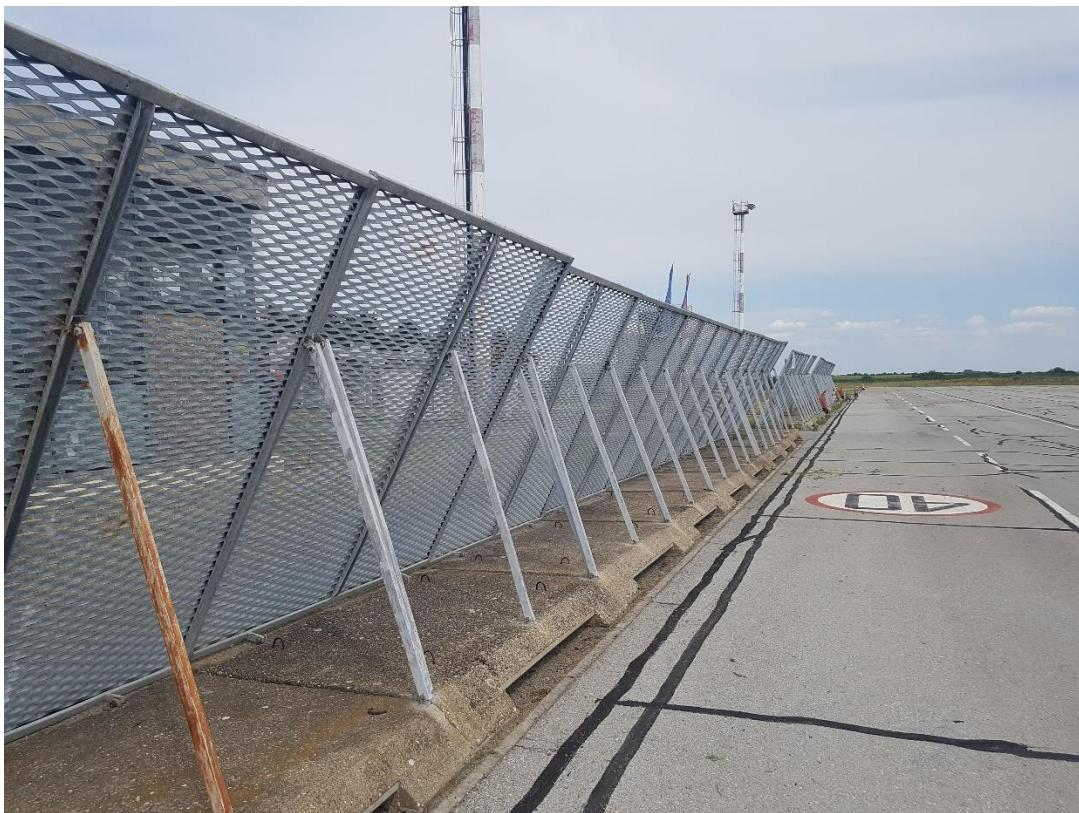
**Slika 25.** Prikaz jet blast deflektora koji su pogrešno postavljeni
