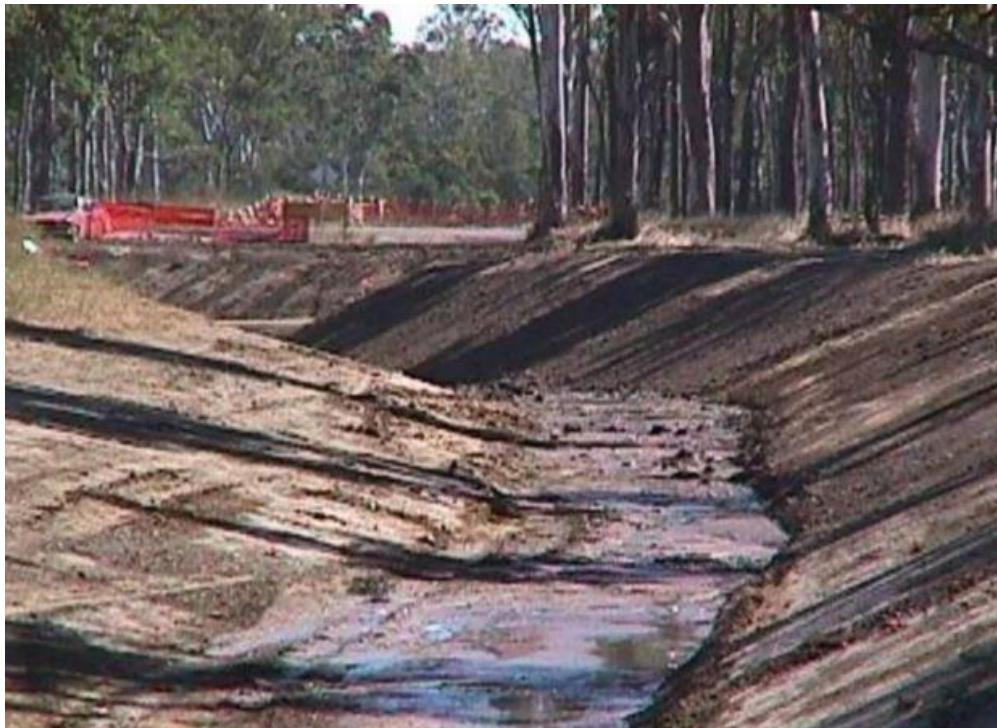
Slika 9. Prikaz zemljanog otvorenog odvodnog kanala
