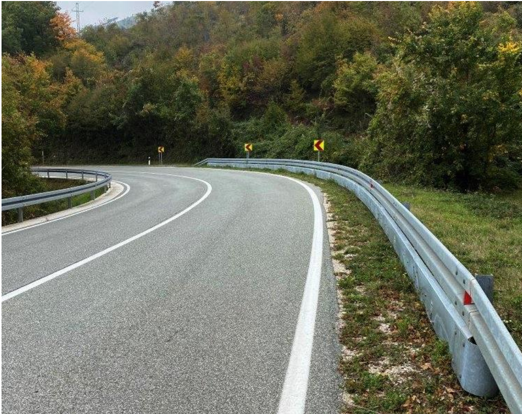
Slika 7. Zaštitna ograda s dodatnim elementom za motocikliste
