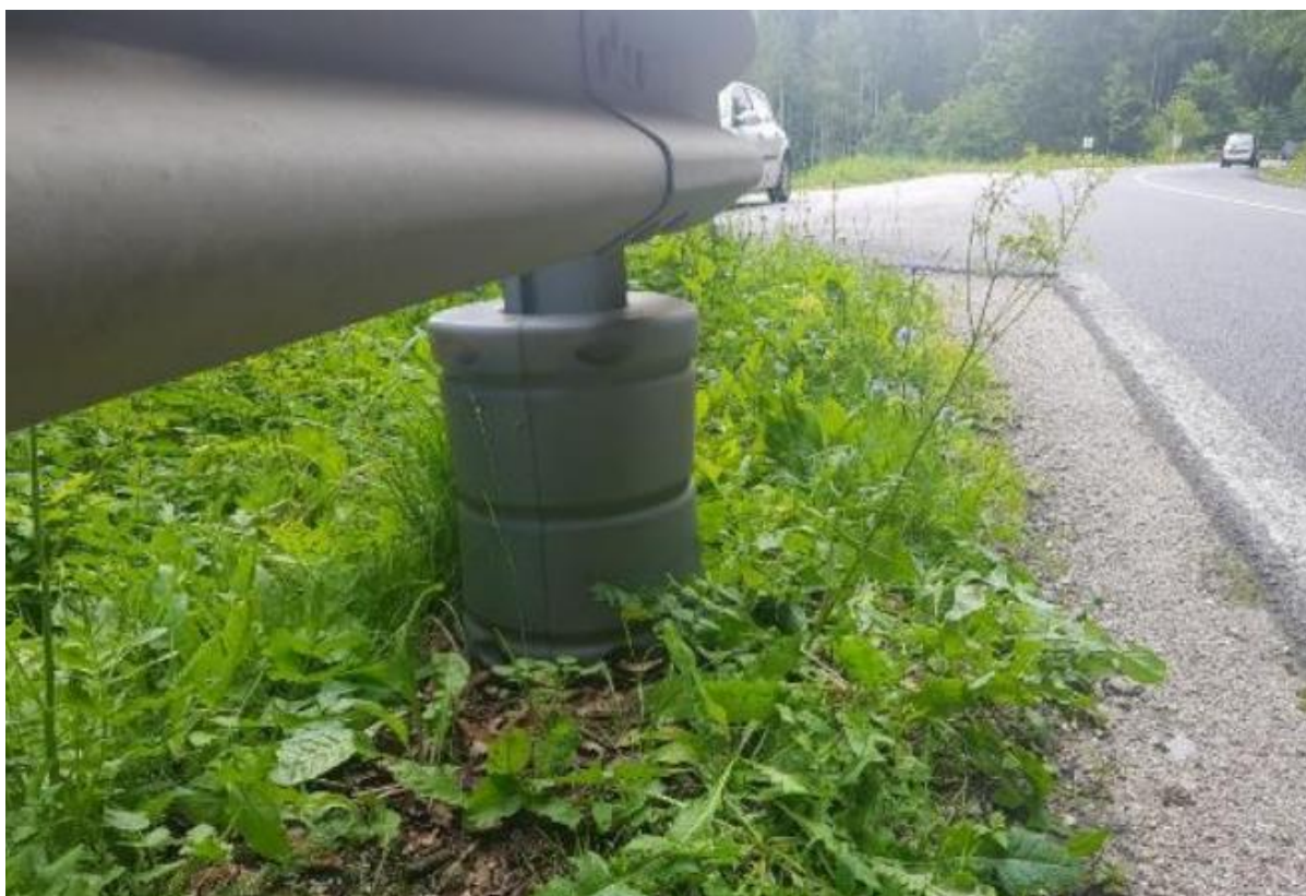
Slika 13. Štitnici stupova zaštitne odbojne ograde
