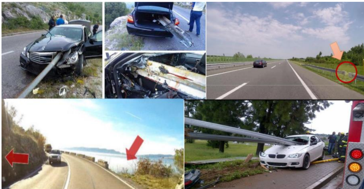
Slika 3. Posljedice neadekvatno postavljene zaštitne ograde
