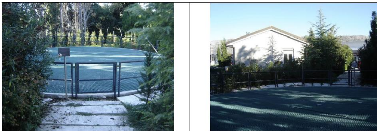
Slika 6. Uređaj i strojarnica uređaja za pročišćavanje otpadnih voda na ZLD Izvor: Poljanec, Z., prof.biol.: Studija o utjecaju na okoliš za zahvat: Proširenje zračne luke Dubrovnik , općina Konavle, Zagreb, 2013., str.25.
