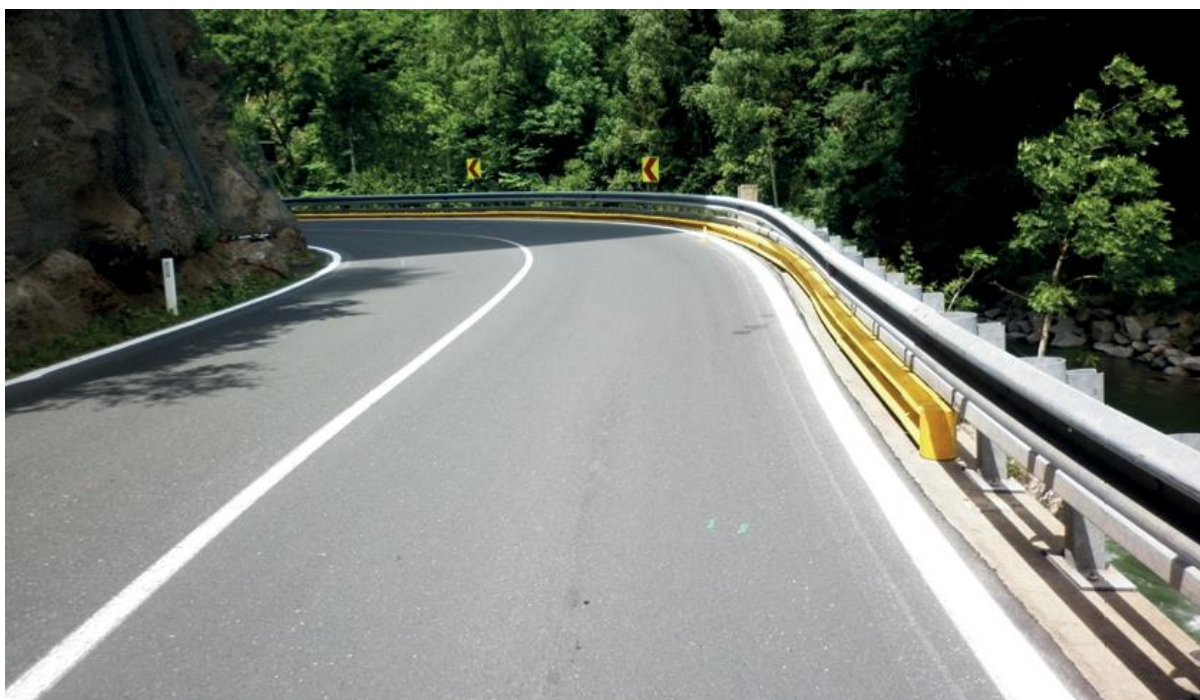
Slika 9. Primjer zavoja označenog pločama za naglašavanje zavoja (Austrija) Izvor: [58]
