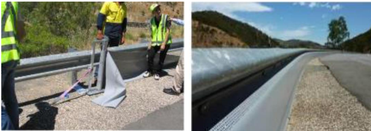
Slika 7. Dodatna zaštita od podlijetanja od tekstila – primjer iz Australije Izvor: [49]
