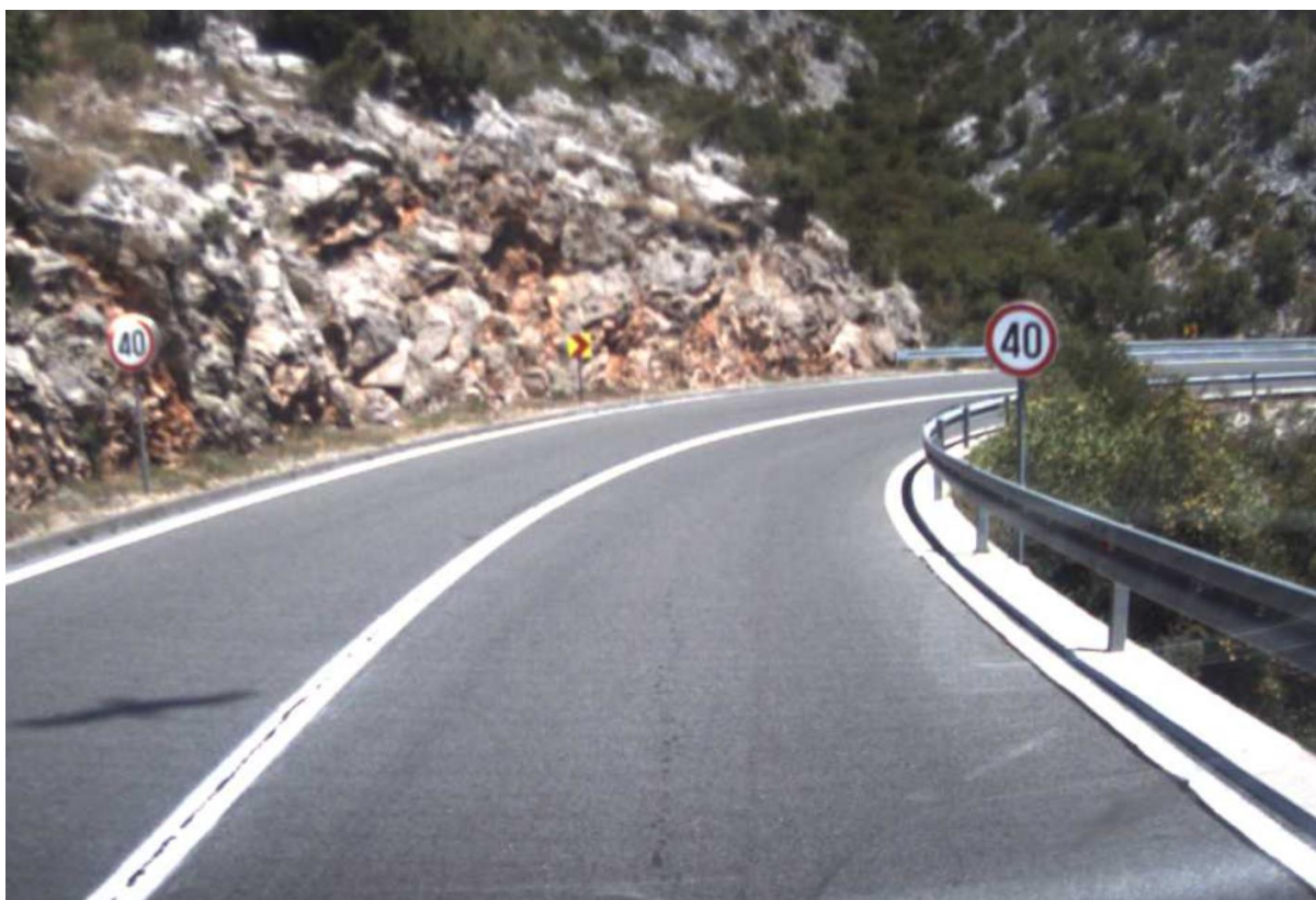
Slika 30. Zavoj opremljen znakovima ograničenja brzine (B30) s lijeve i desne strane, pločama za označavanje zavoja (K11-1) i dodatnom zaštitom od podlijetanja (DC8)
