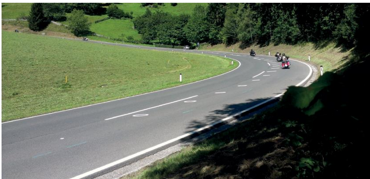
Slika 16. Elipsoidne oznake u zavoju Izvor: [58]
