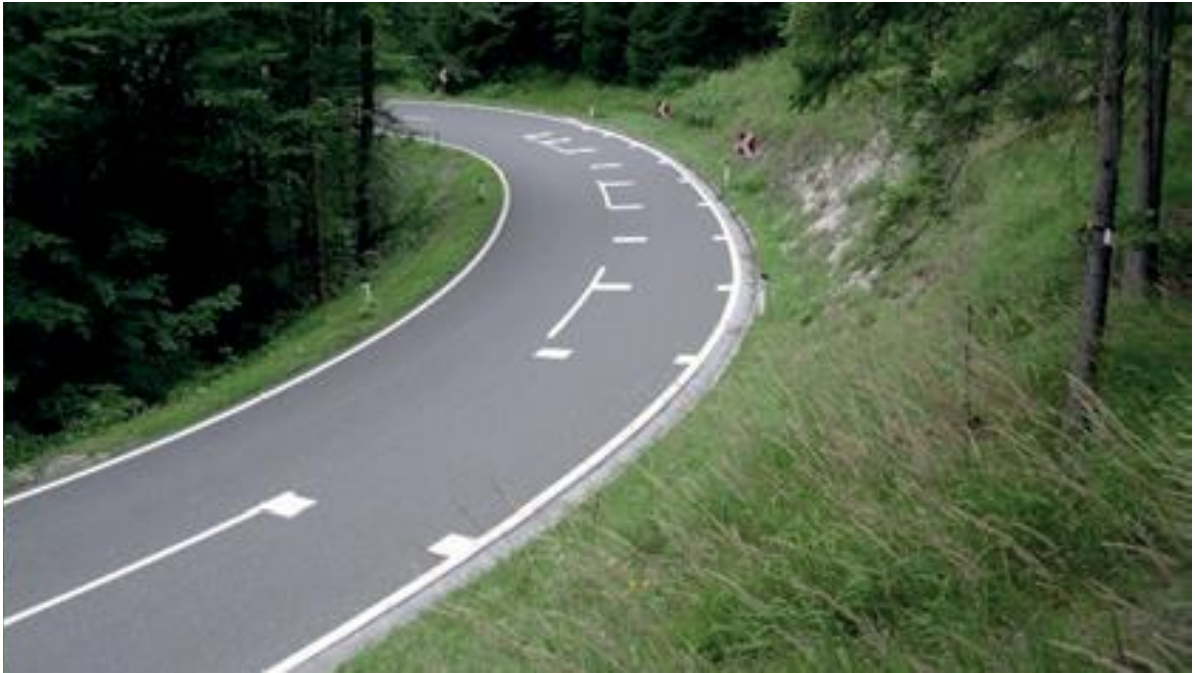
Slika 20. Oznake u obliku crta okomitih na središnju crtu, s pomoćnim crtama uz rubnu crtu Izvor: [58]
