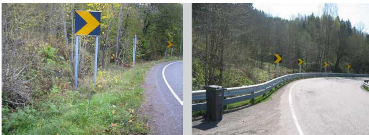
Slika 10. Označavanje zavoja i zaštitna ograda – primjer iz Norveške
