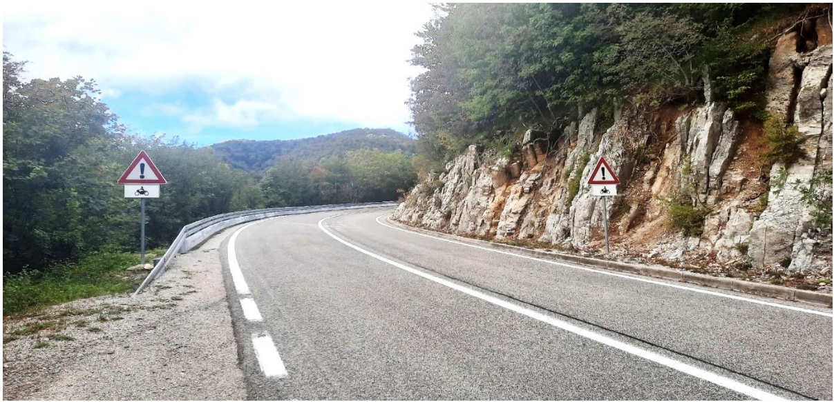
Slika 31. Znakovi opasnosti (A01) s lijeve i desne strane kolnika s dopunskim pločama sa simbolom motocikla (E06-7)
