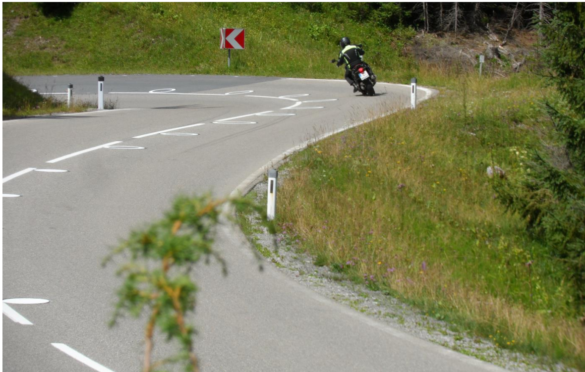
Slika 18. Elipsoidne oznake u zavoju Izvor: [60]
