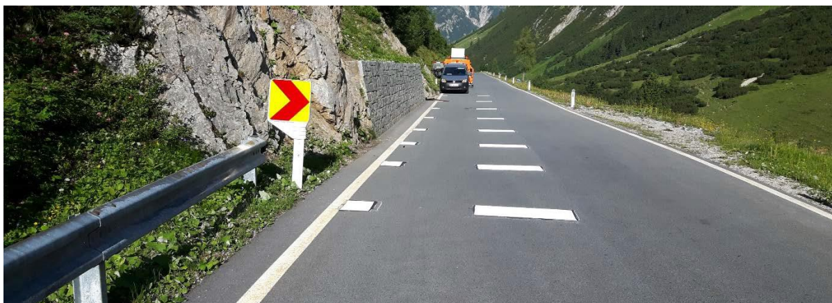
Slika 13. Oznake na kolniku namijenjene za usporavanje motociklista na pravcu Izvor: [60]
