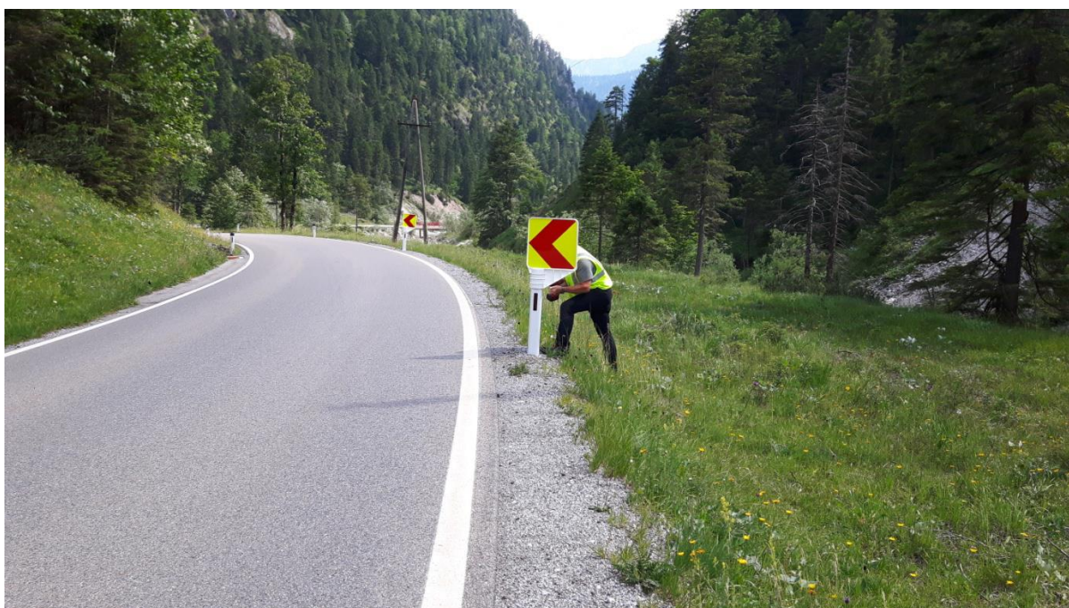
Slika 12. Ploče za označavanje zavoja na plastičnom stupu
