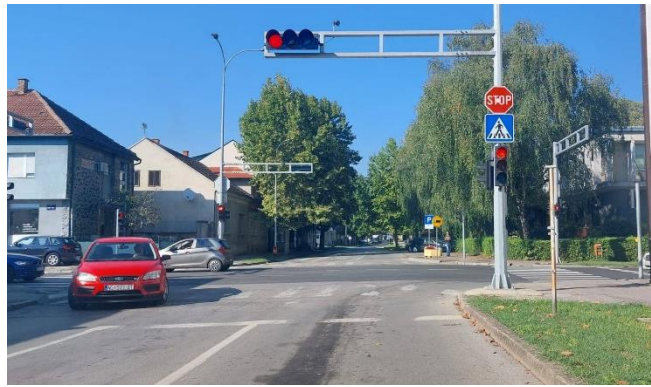
Slika 32. Semaforizacija sporednog pravca
