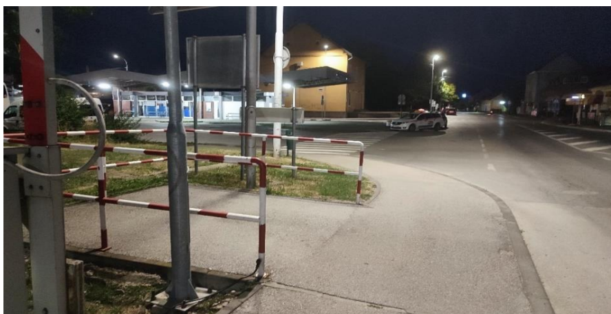
Slika 18. Polovična mimoilazna zaštitna ograda
