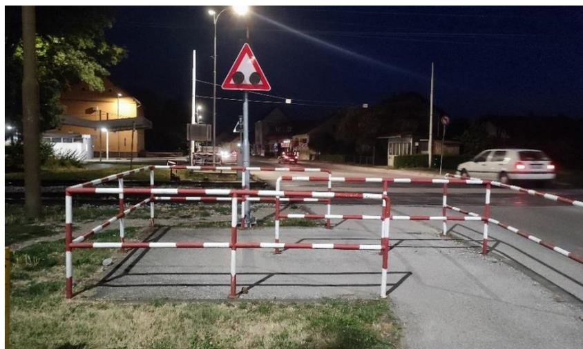
*Slika 11. Mimoilazna zaštitna ograda na željezničko-cestovnom prijelazu*
