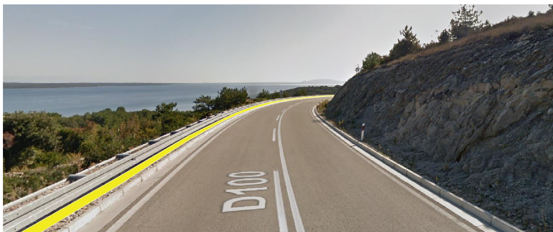
Slika 37: Prikaz dodatne zaštite za motocikliste na postojećoj ogradi
