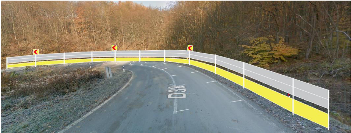
Slika 26: Prikaz posebne sigurnosne zaštitne ograde i linija vodilja
