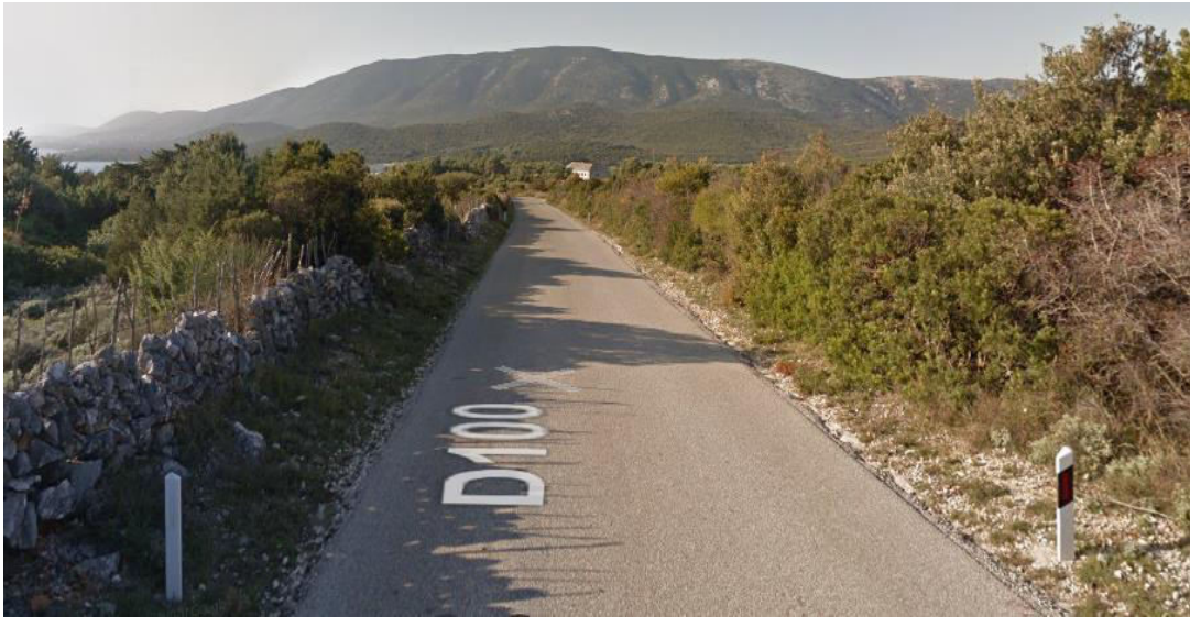
Slika 34: Prikaz trenutnog stanja odabrane lokacije za postavljanje reflektora za odvracanje divljači
