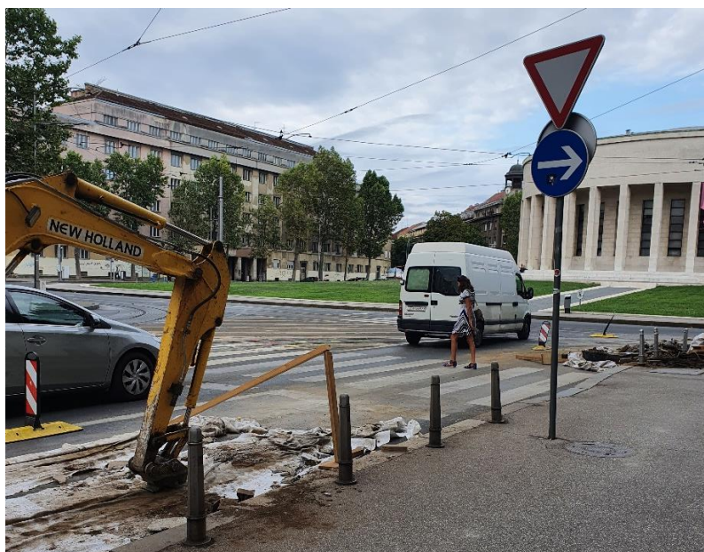
Slika 75. Pješački prijelaz na privozu te konfliktna točka sa tramvajskom prugom
