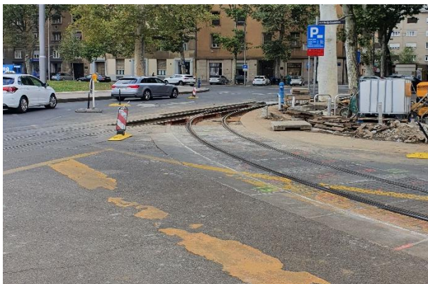
Slika 68. Radovi na izmjeni kolosijeka u samome križanju
