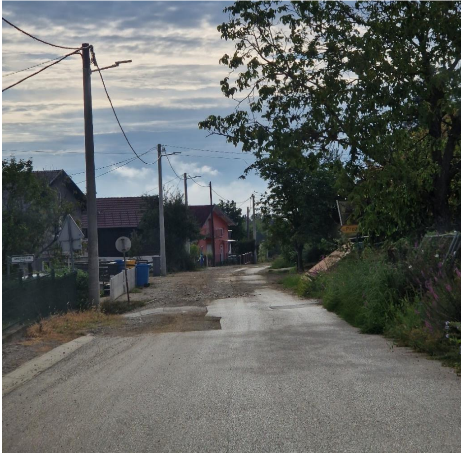
Slika 17. Trenutno stanje kolnika u Martinskoj ulici - kolovoz, 2022. godine
