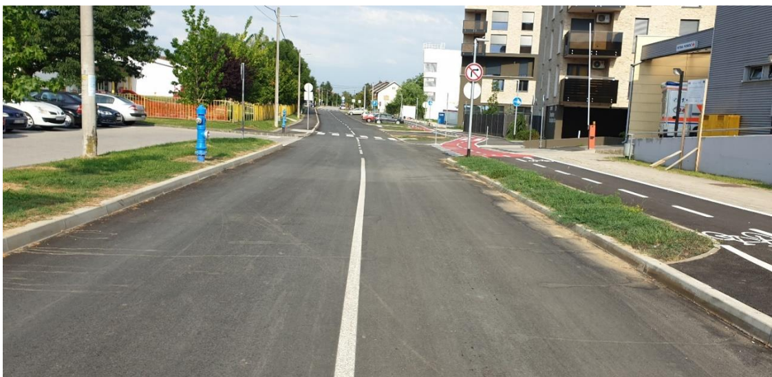
Slika 13. Ulica Dragutina Domjanića nakon rekonstrukcije - lipanj, 2022. godine
