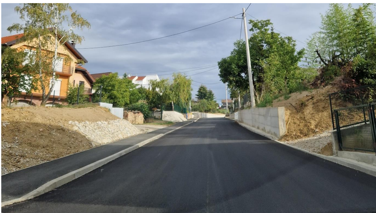
Slika 11. Trenutno stanje Šaškovečke ulice - kolovoz, 2022. godine
