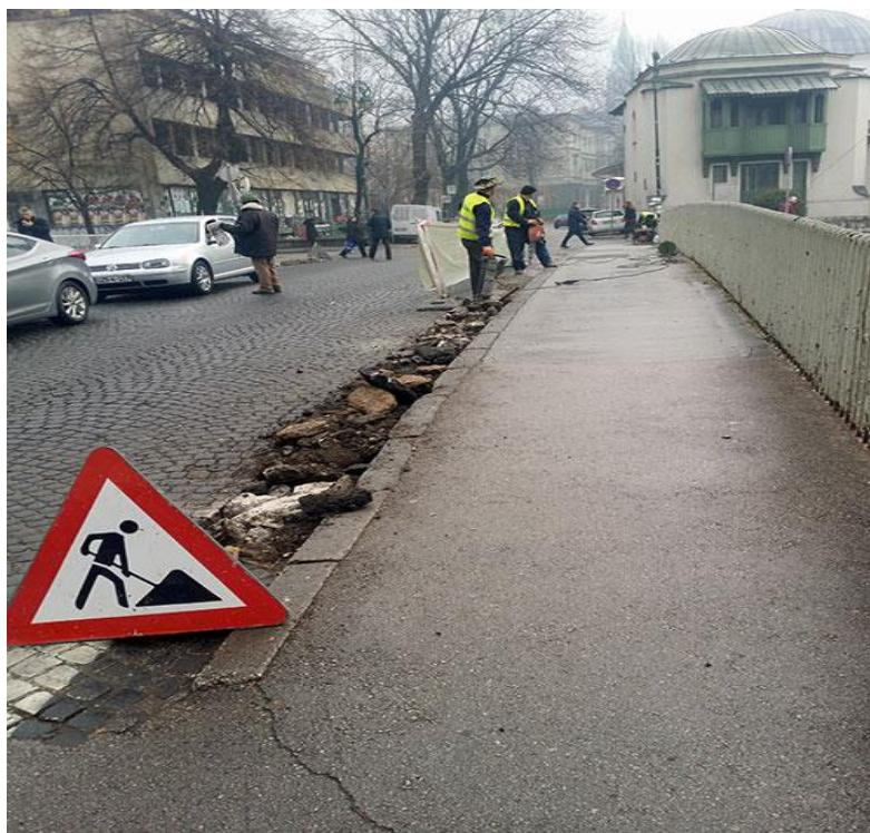
**Slika 7.** Radovi na sanaciji betonskih rigola
