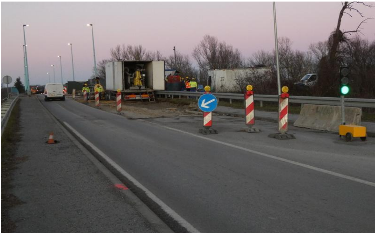
Slika 11. Zamjena kolnika na mostu Brest
