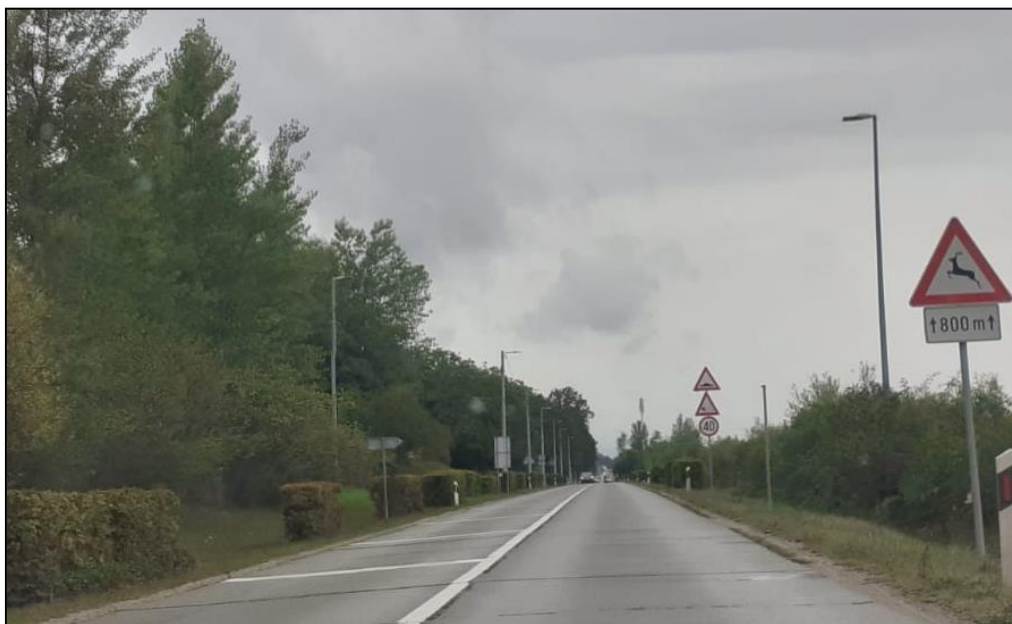
Slika 21. Stanje na dionici trase državne ceste DC 231 između mosta preko rijeke Gradne i raskrižja s Ulicom Ante Starčevića
