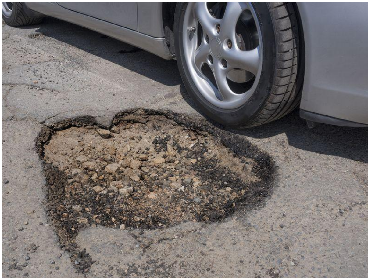
Slika 12: Oštećenje kolnika
