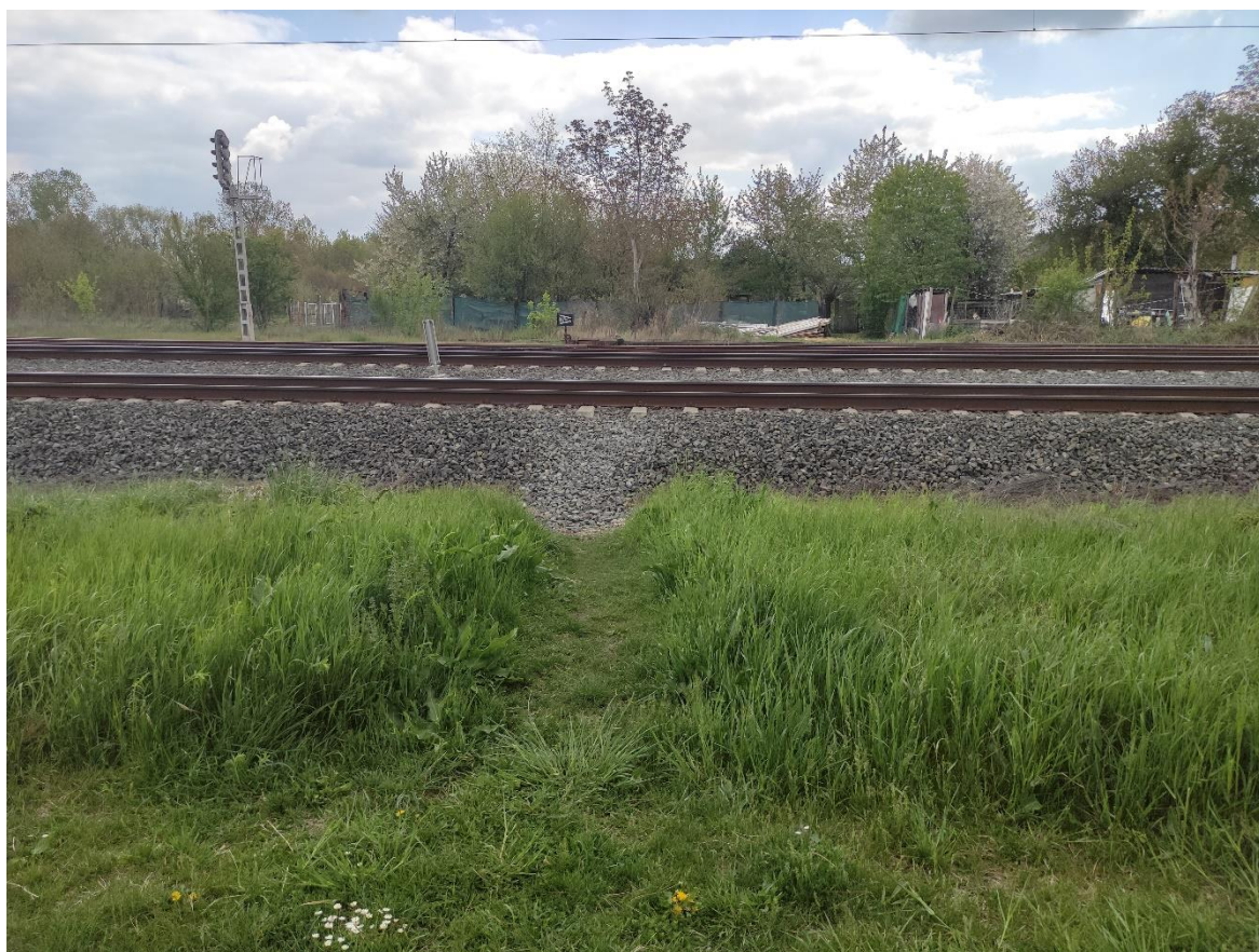
Slika 29 Lokacija 14 - „divlji“ prijelaz preko željezničke pruge [24]
