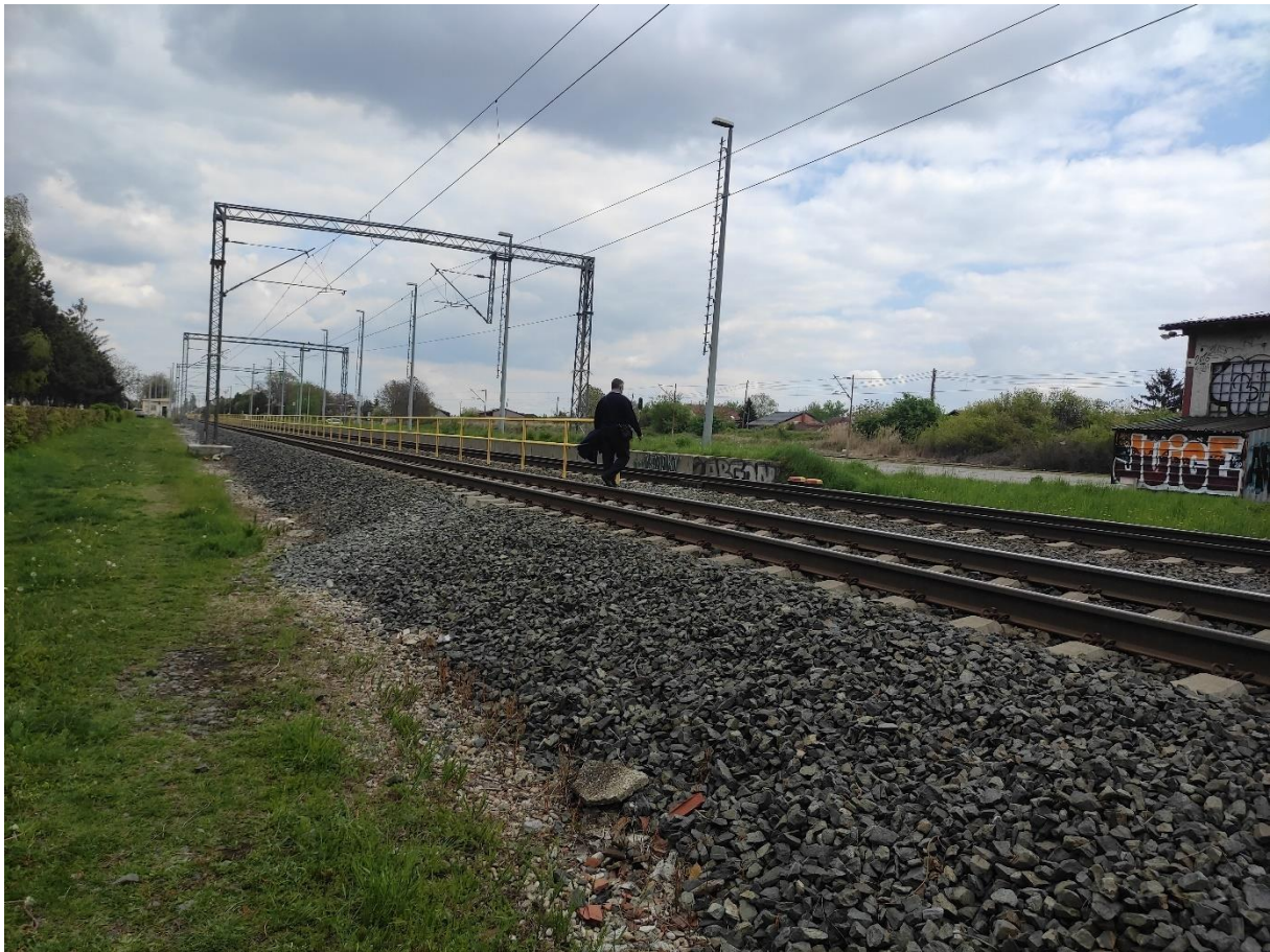
Slika 33 Primjer nepropisnog prelaska preko željezničke pruge na lokaciji 18 [24]
