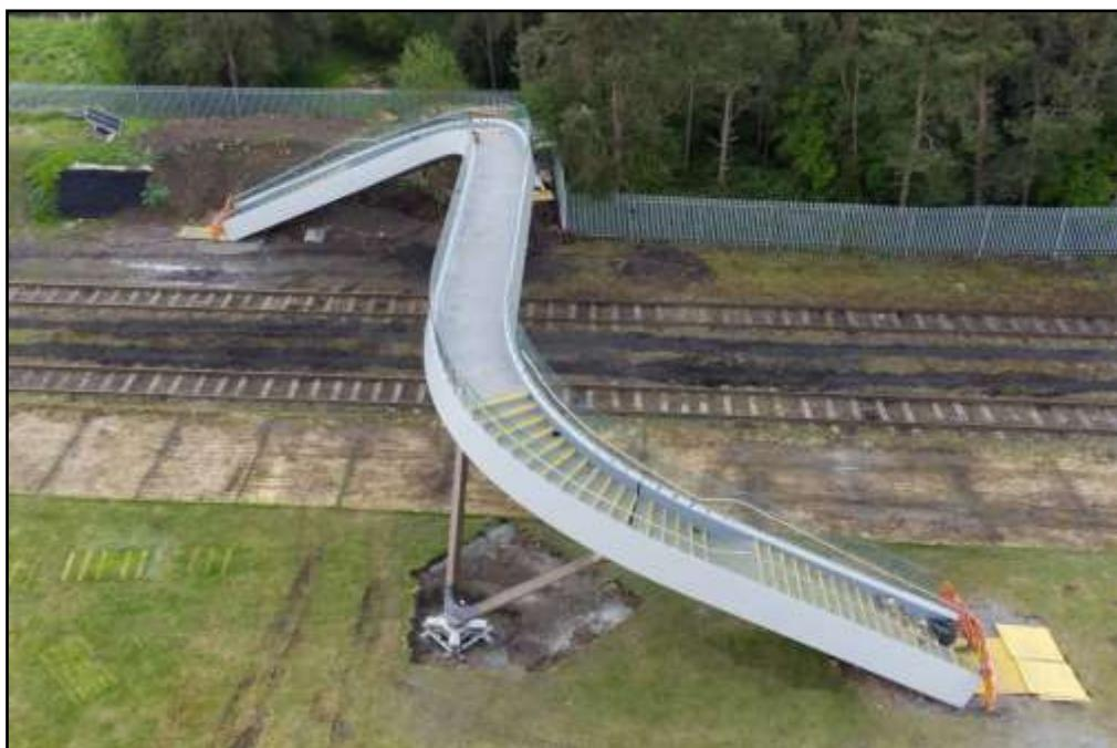
Slika 43. Prototip nathodnika „Flow footbridge“ na testnoj stazi u Warwickshire-u u Engleskoj, [18]
