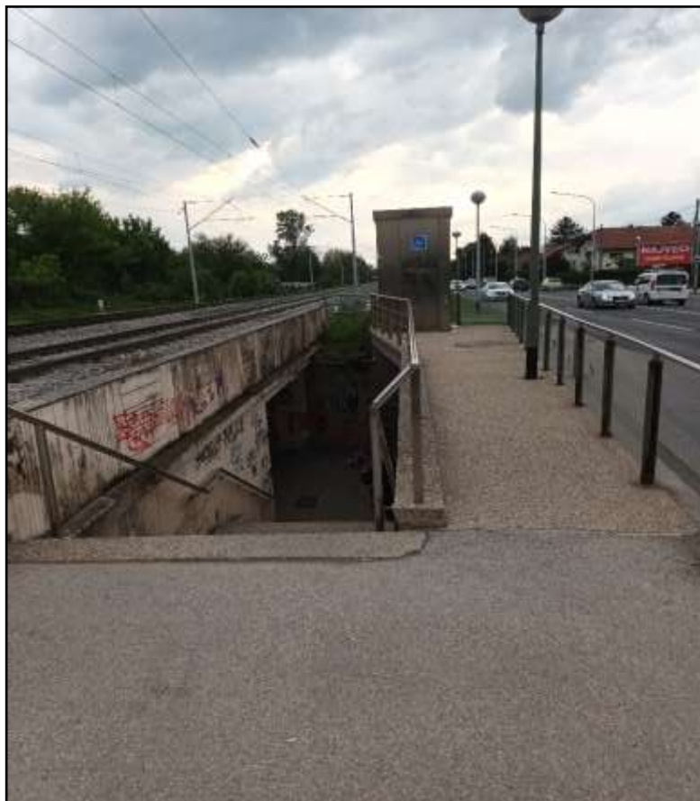
Slika 31. Ulaz/izlaz broj 2 pothodnika na zapadnoj lokaciji
