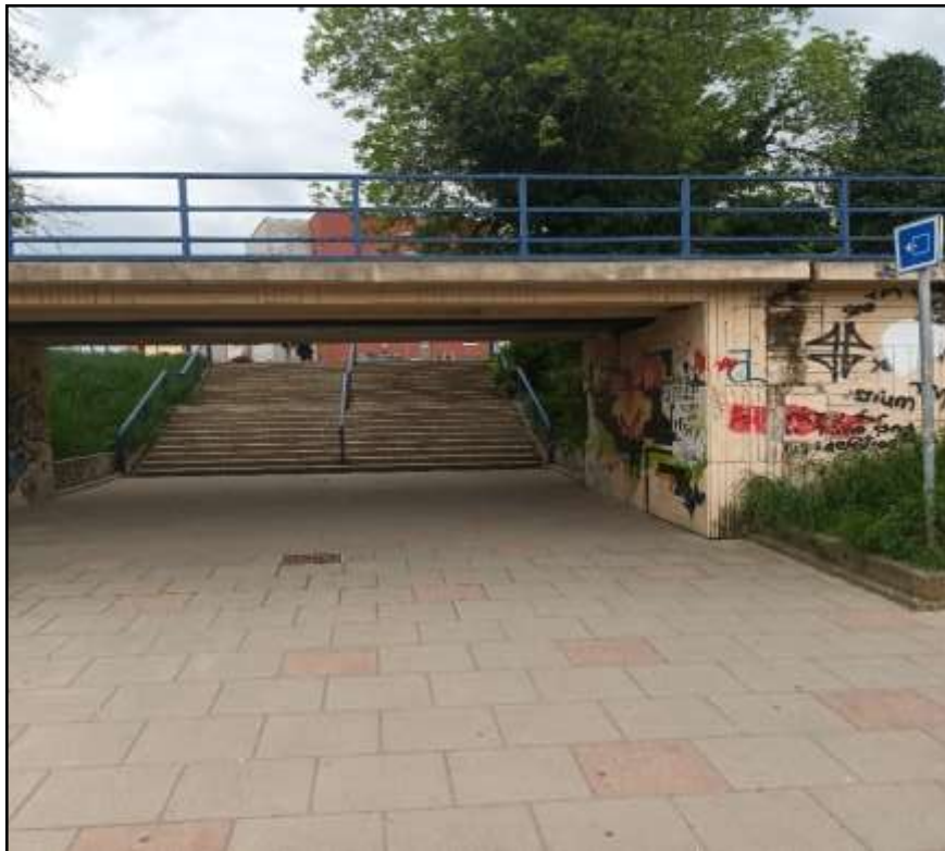
Slika 33. Ulaz/izlaz broj 4 pothodnika na zapadnoj lokaciji
