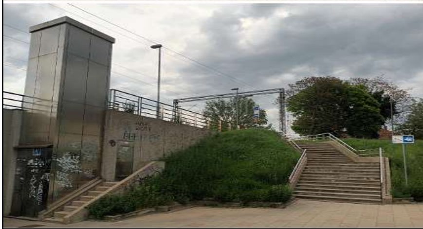
Slika 32. Ulaz/izlaz broj 3 pothodnika na zapadnoj lokaciji
